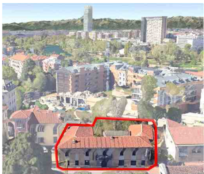
Ripresa aerea verso sud-ovest
