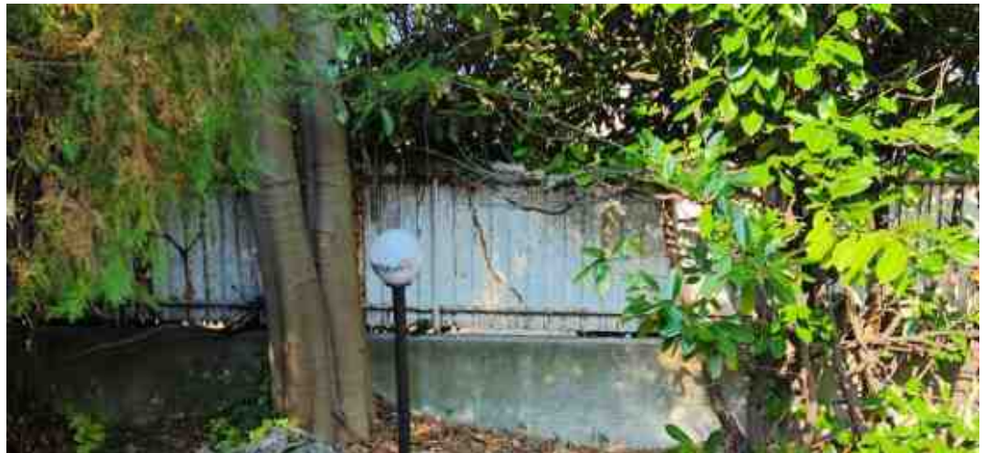
Foto della recinzione esistente
