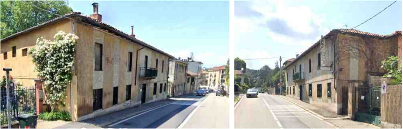
Viste prospetto prospiciente su Via Sabaudia
