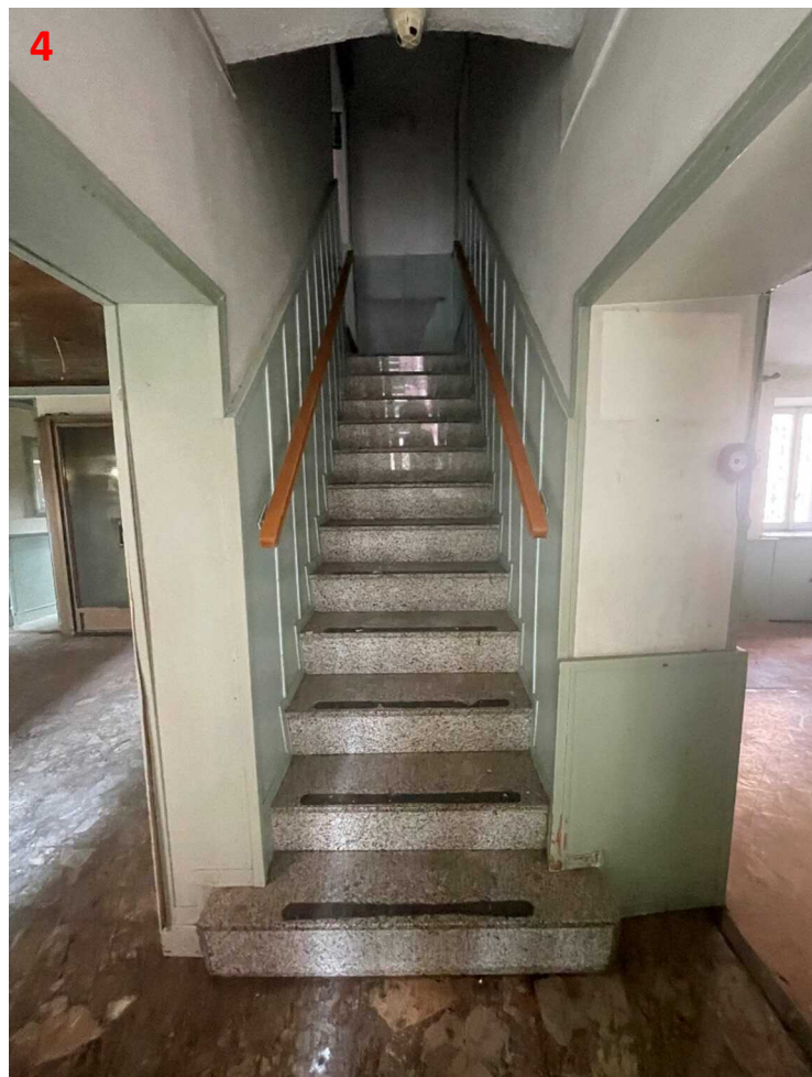
Vista 4 – scale per piano primo
