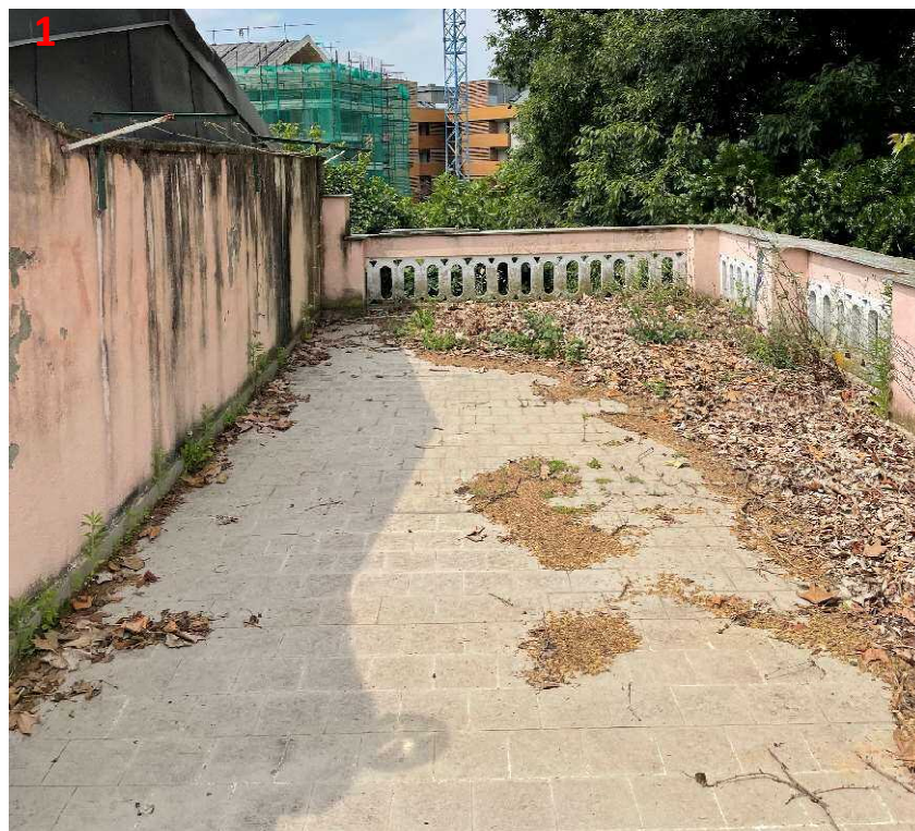
Vista 1 – terrazzo esterno del basso fabbricato
