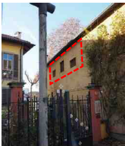
Stato di fatt. Facciata su via Sabaudia 12
