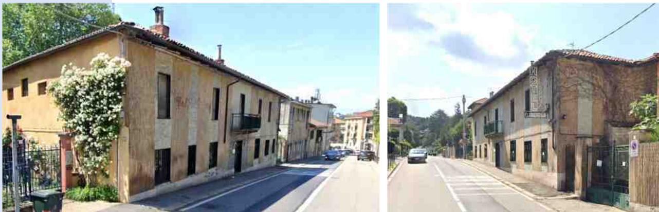
Viste prospetto prospiciente su Via Sabaudia
