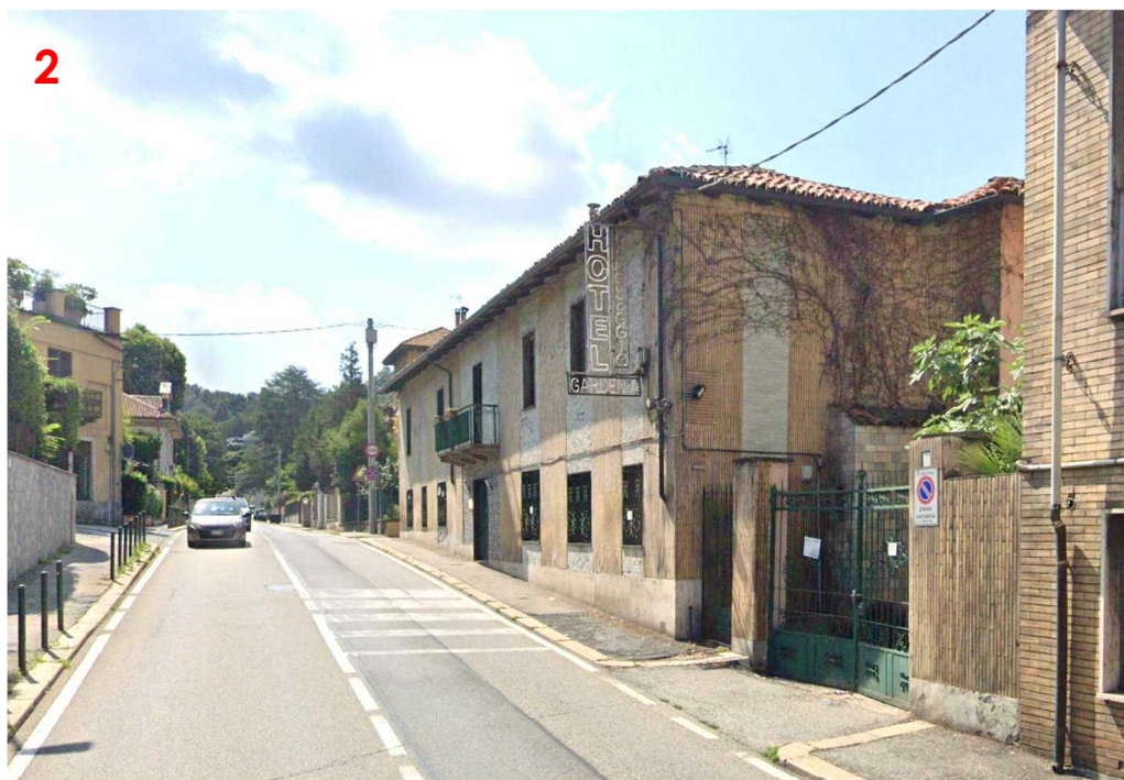
Vista prospetto prospiciente su Via Sabaudia
