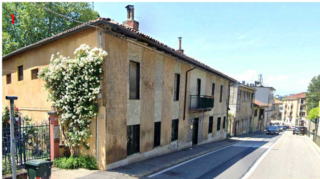
Vista prospetto prospiciente su Via Sabaudia
