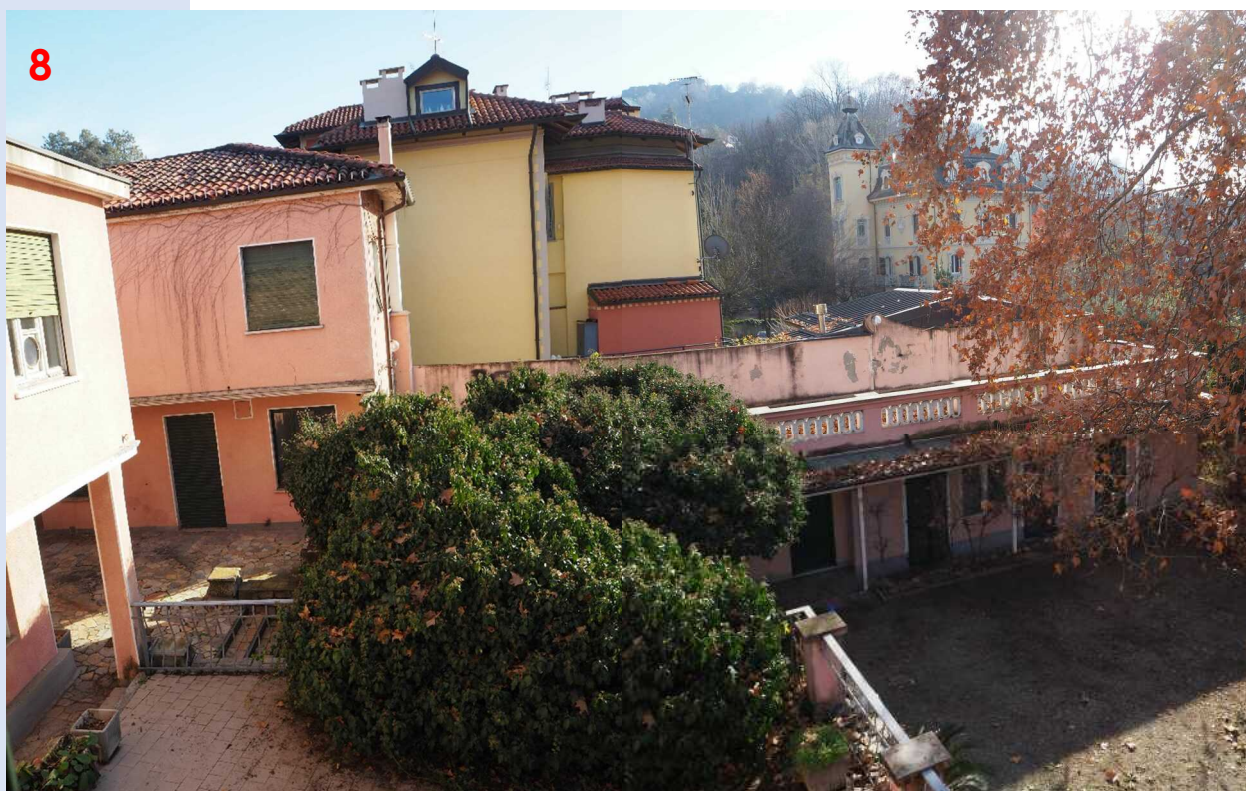
Vista del prospetto Nord Ovest. L'immagine è stata ricostruita attraverso la sovrapposizione di due fotografie.
