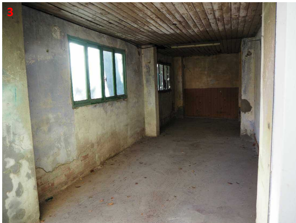
Vista 3 – Interno autorimessa
