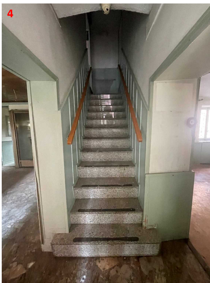
Vista 4 – scale per piano primo
