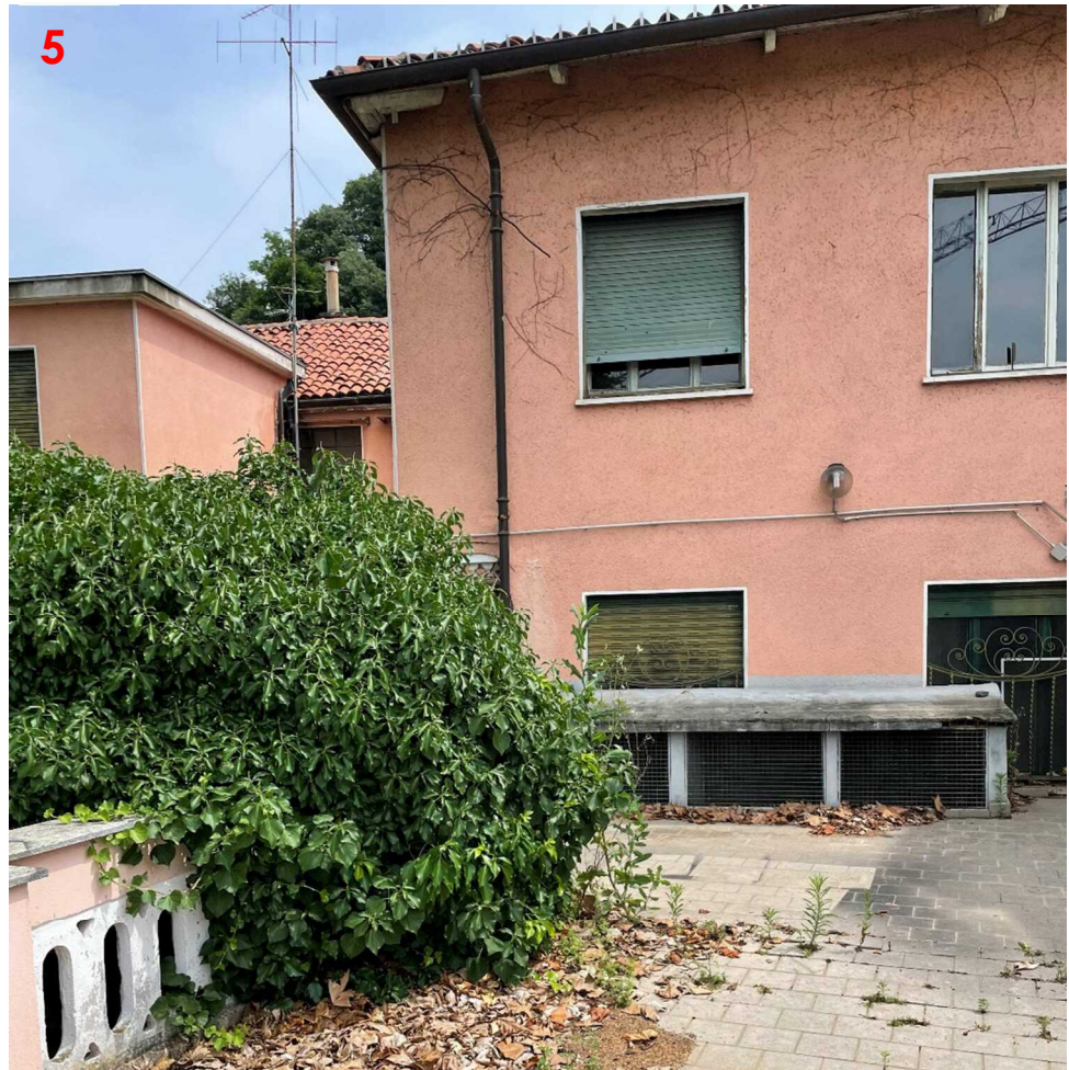
Vista del prospetto Sud Ovest lato terrazzo
