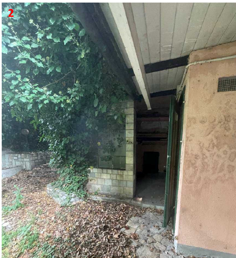
Vista 2 – vano tecnico in prossimità delle scale di ingresso
