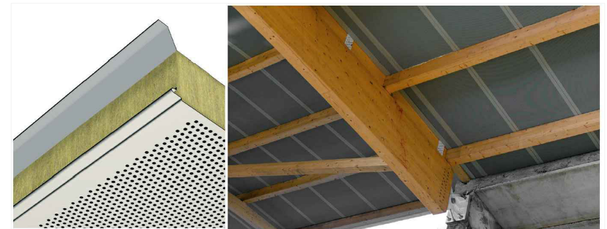
Dettaglio tipologia sistema di copertura con lamiera microforata e pannello di coibentazione
