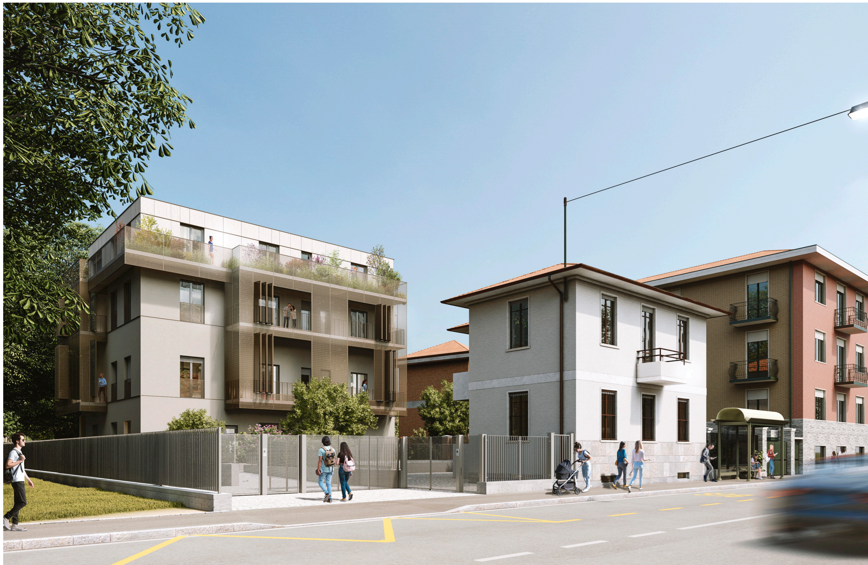
1. VISTA DEL PROSPETTO PRINCIPALE E DELL'ACCESSO PEDONALE E CARRAIO DA CORSO CASALE 263/A
