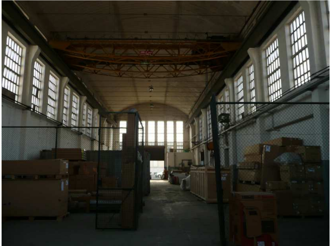
interno via Capelli n. 87
