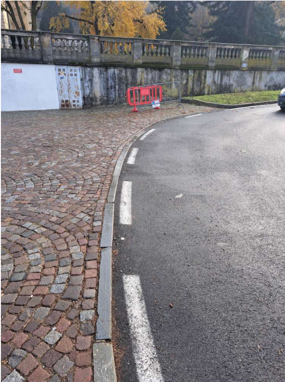
Pavimentazione in porfido da manomettere
