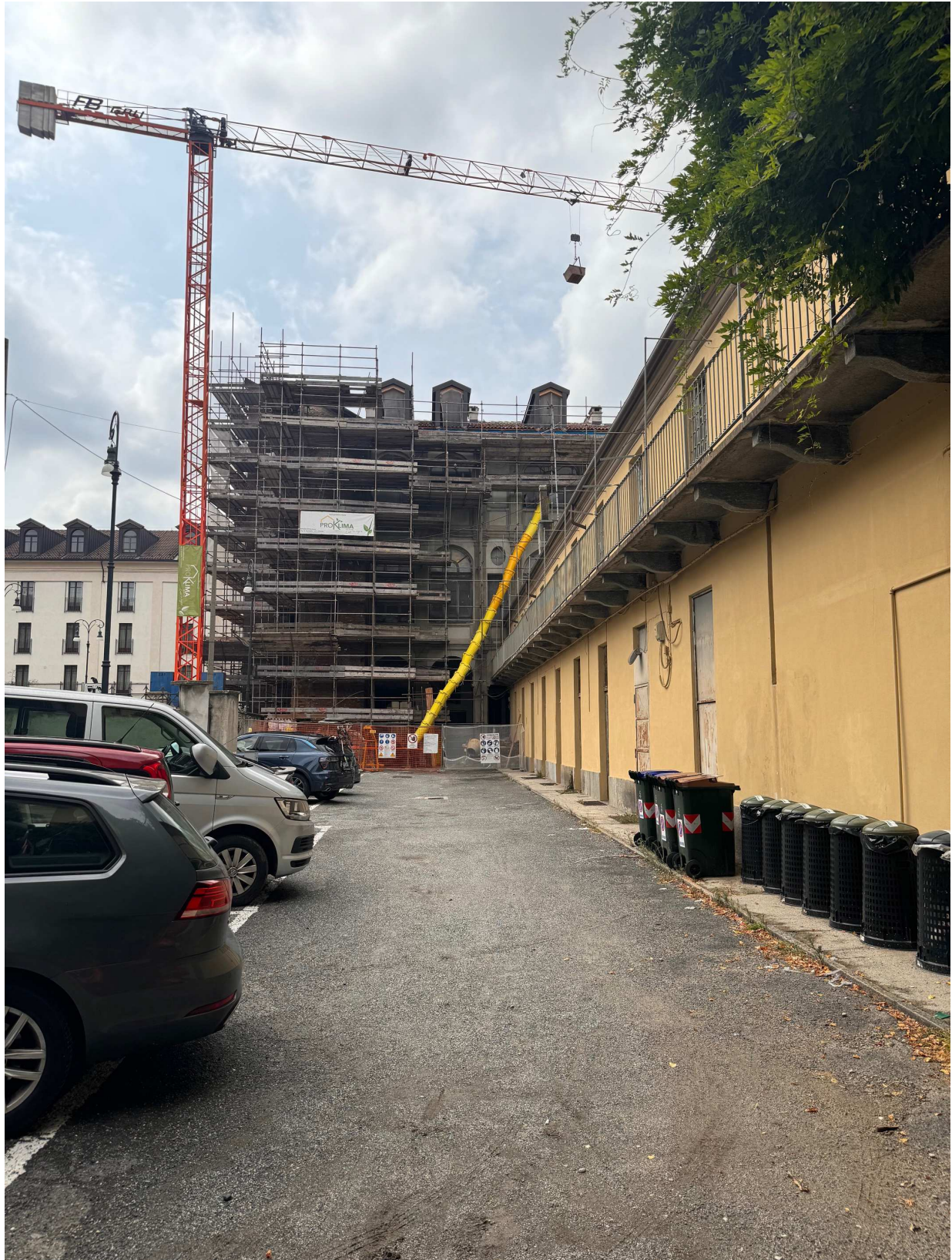
Il cortile lungo via Egidi, vista verso via della Basilica
