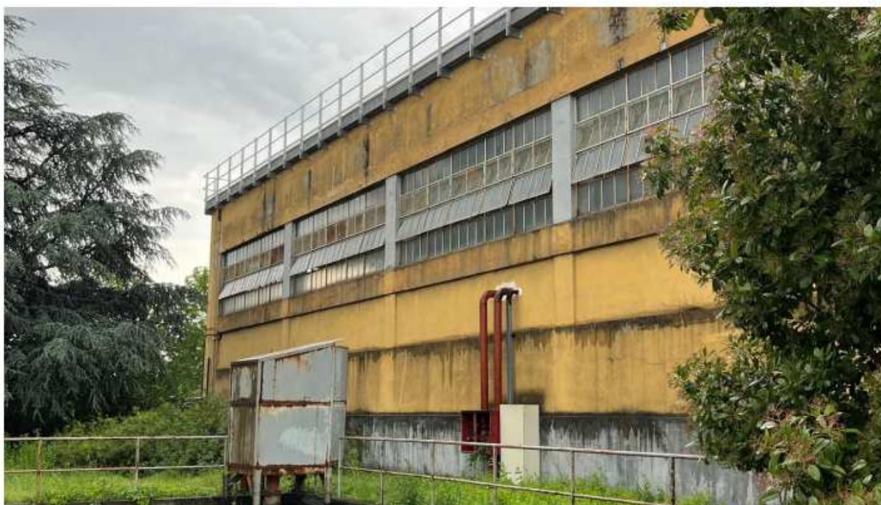
Vista interna fabbricato lato Nord
