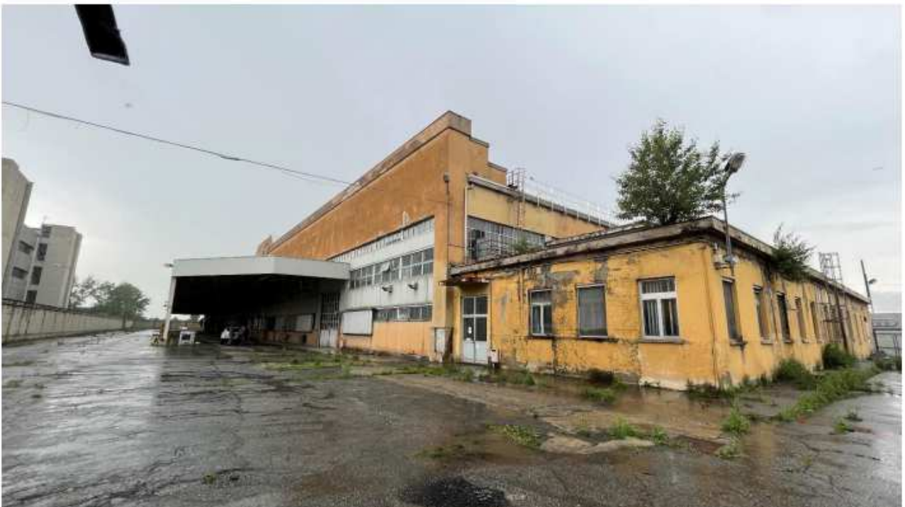
Vista interna fabbricato angolo Sud - Ovest
