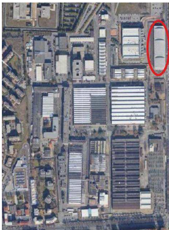
Vista Area Alenia fabbricato n.37 - stato attuale
