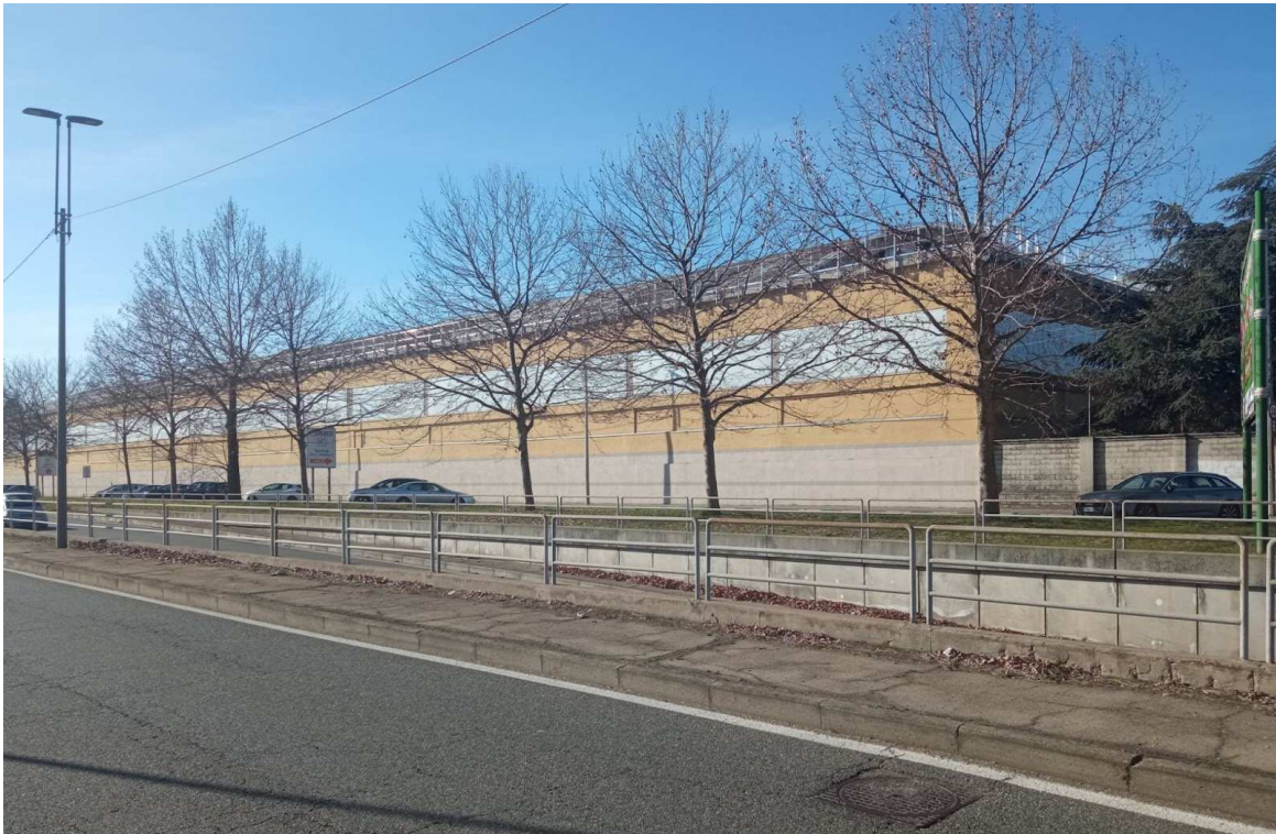
Vista angolo fabbricato - Nord - Est
