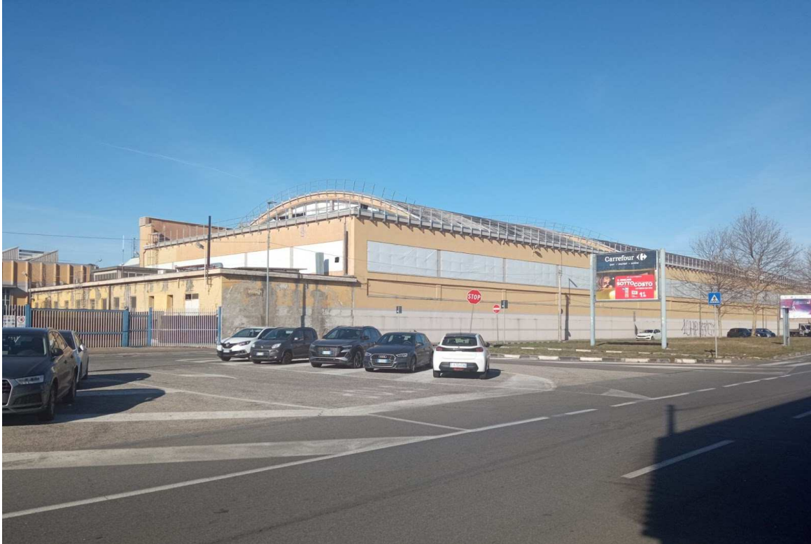
Vista angolo fabbricato - Sud - Est
