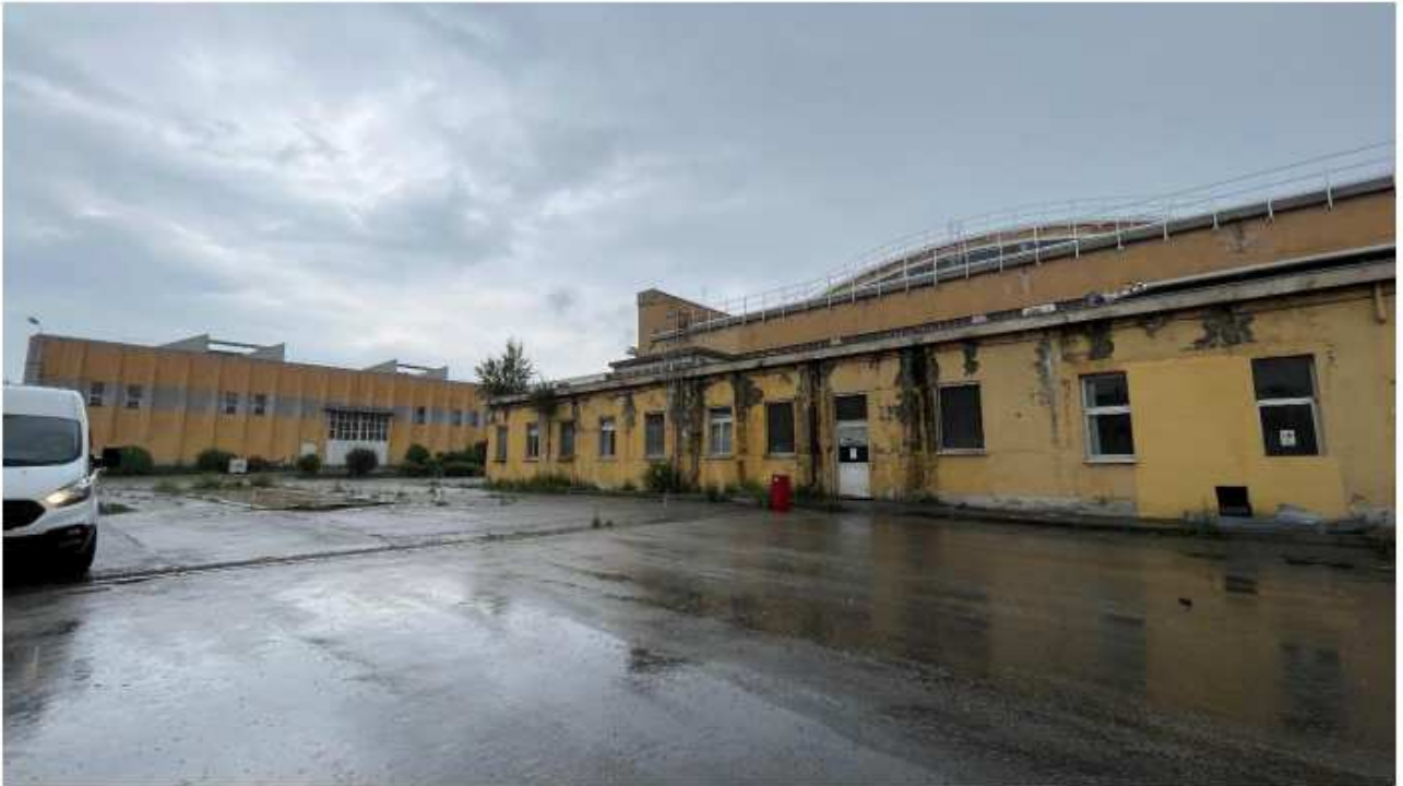
Vista interna fabbricato lato Sud
