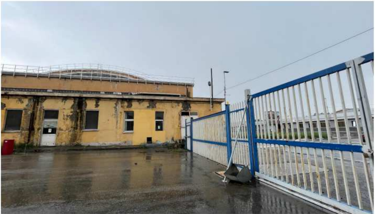
Vista fianco interno fabbricato - ingresso Corso Marche n.43
