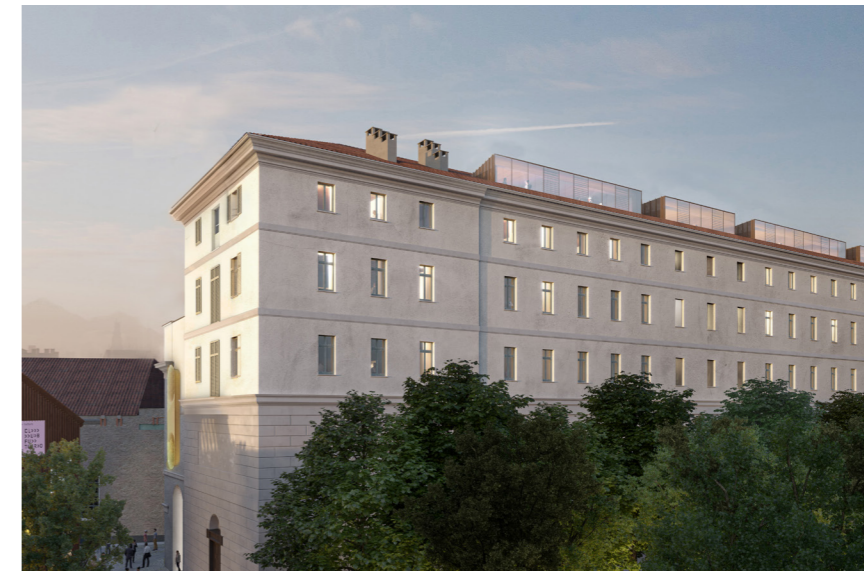
Veduta del fronte nord
