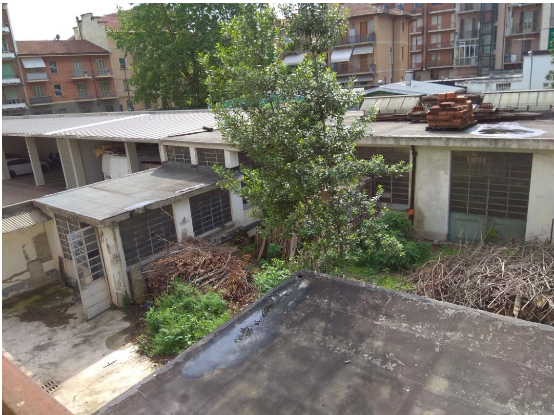
Foto 4 – Vista da cortile interno
