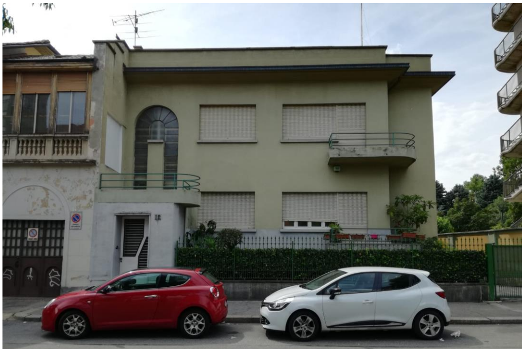
Foto 2 – Vista da Corso Brunelleschi
