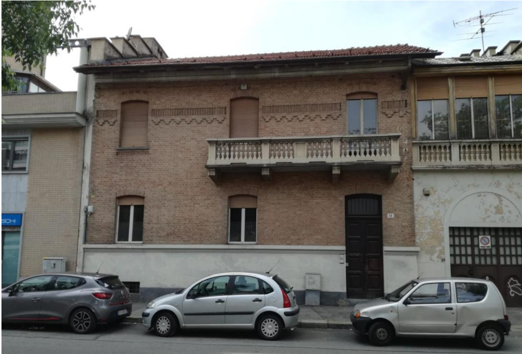
Foto 1 – Vista da Corso Brunelleschi
