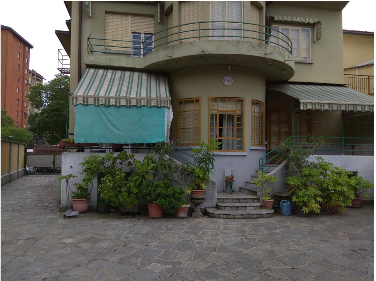
Foto 3 – Vista da cortile interno
