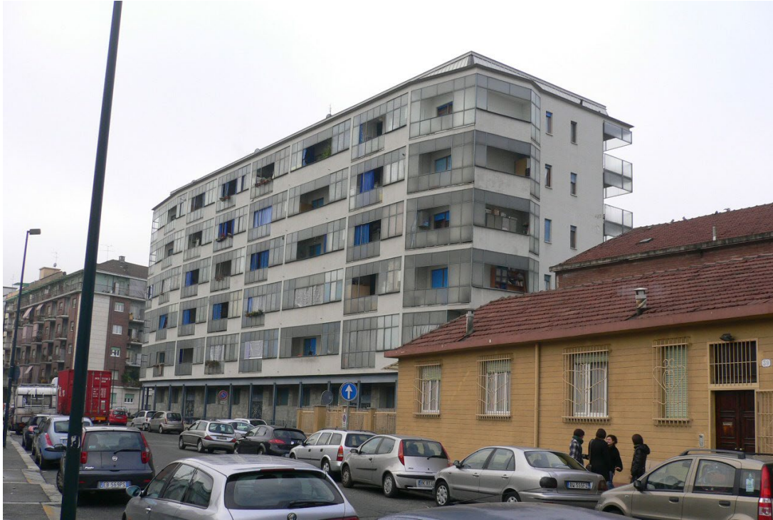
Foto 1 – Strada Basse di Dora
