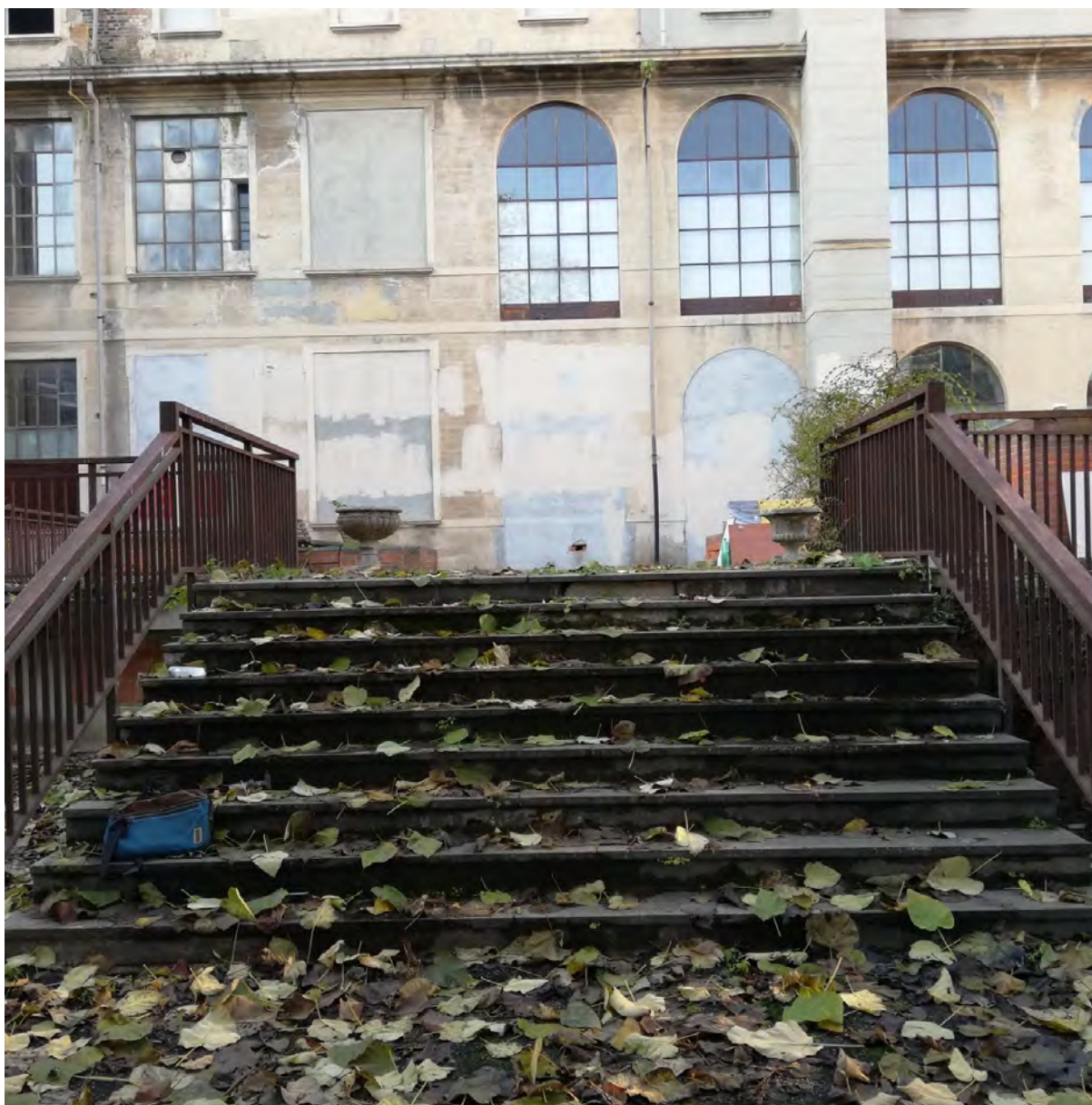
RAMPA SCALE ESISTENTE
