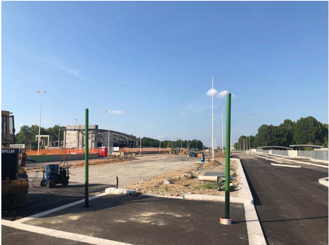
Figura 10 – Vista da rotonda corso Venezia verso stazione Rebaudengo
