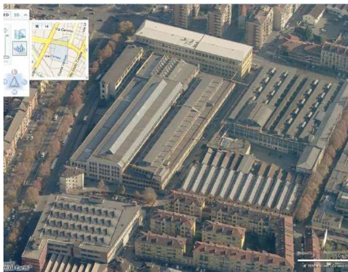
Vista aerea da ovest – area nord
