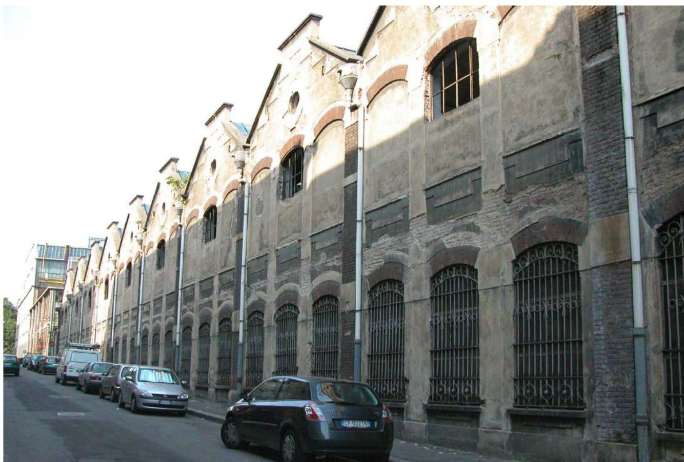
16.Edificio Fenoglio - Via Damiano
