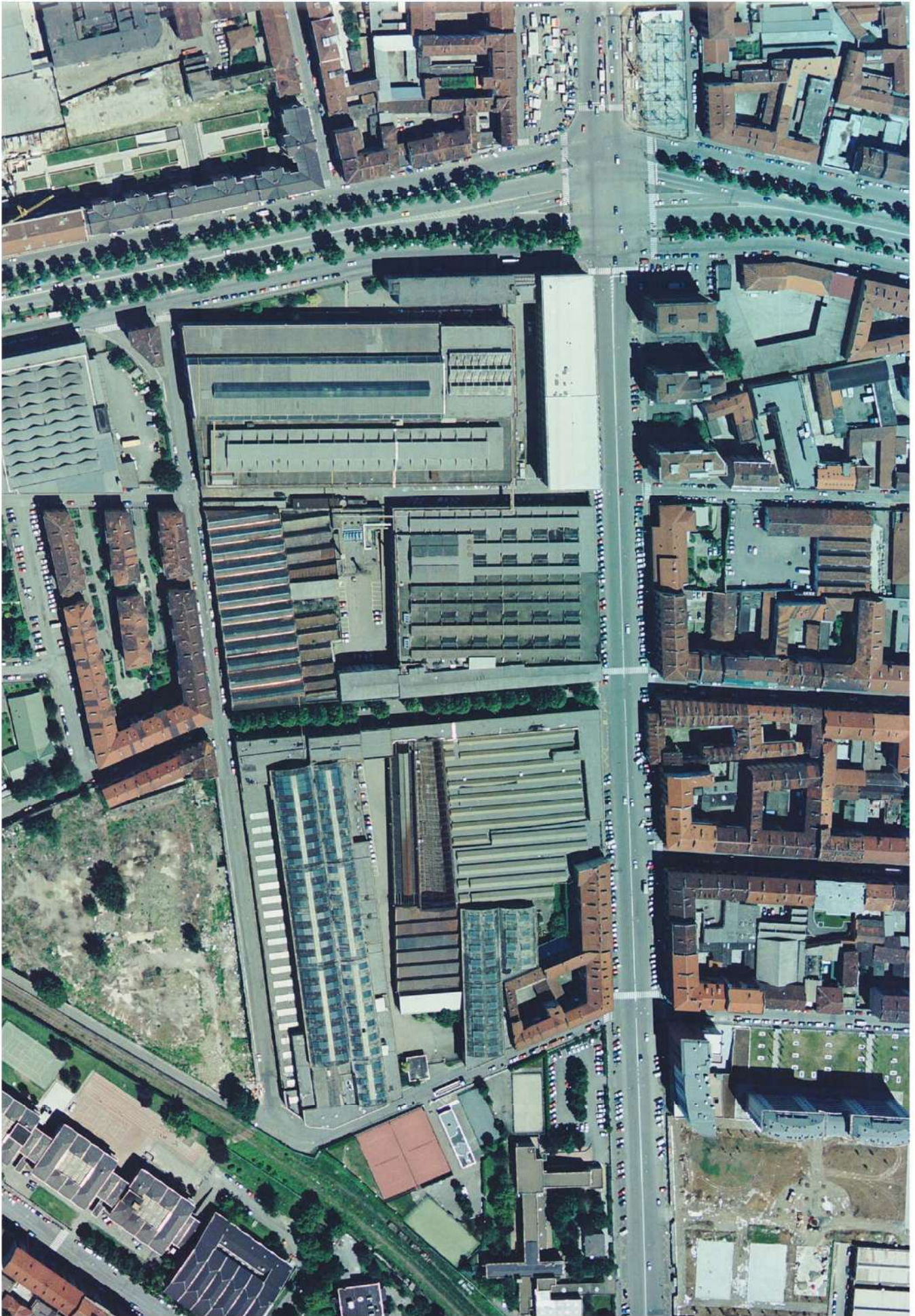
Vista aerea dell'area di intervento prima delle demolizioni (2007)
