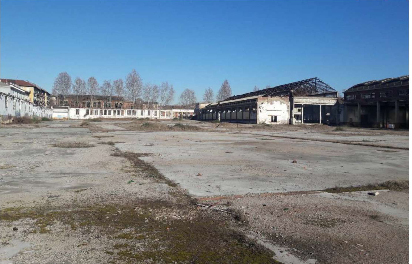
18.Vista dell'area a sud di Via Cuneo
