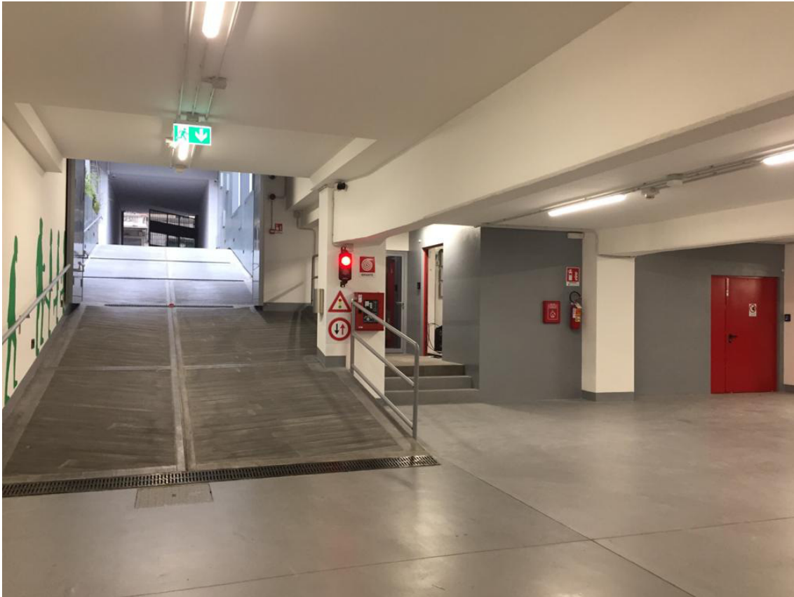
FIG.3 – Vista sulla rampa dall'interno dell'autorimessa
