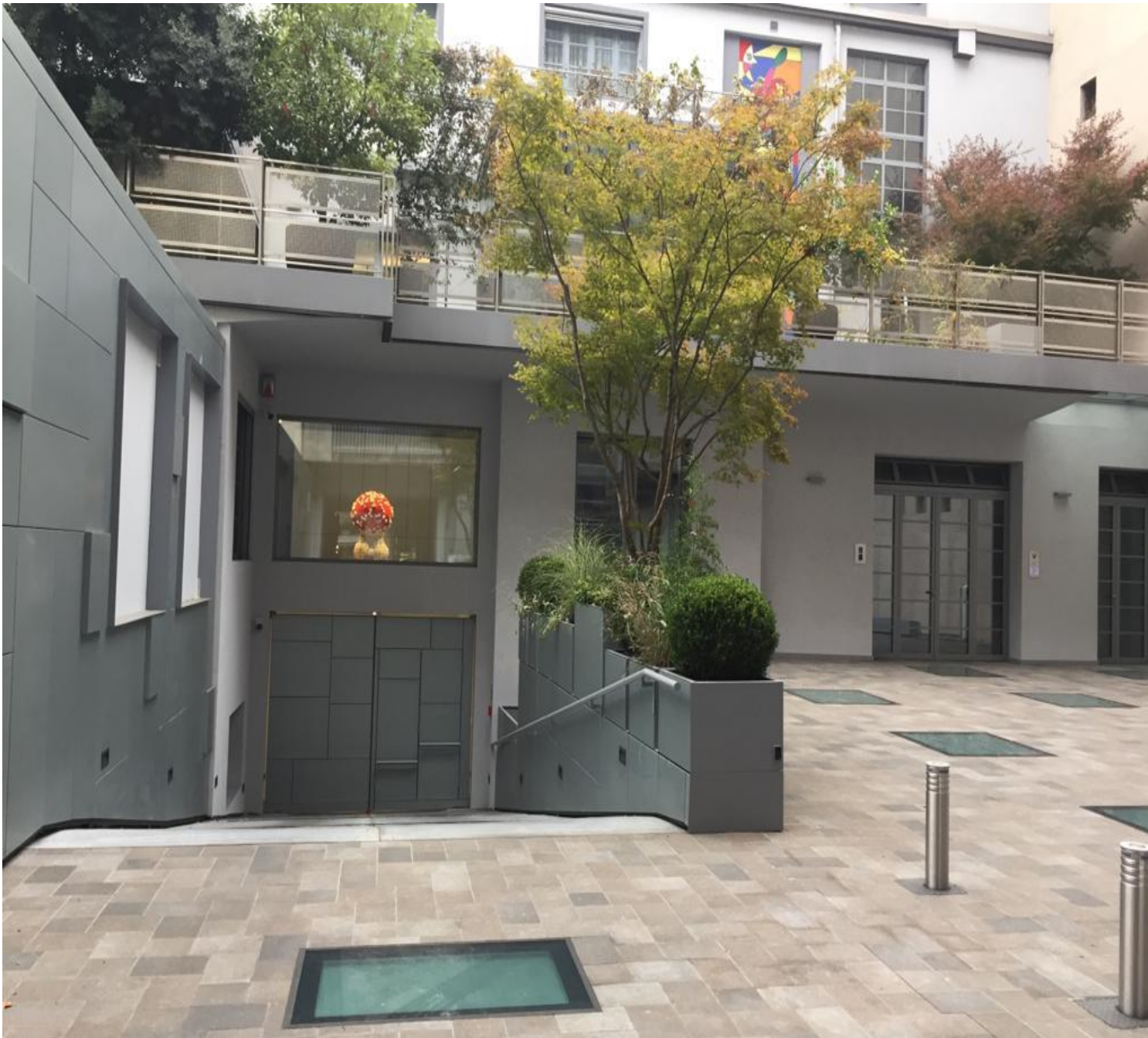
FIG.2 – Interno cortile con vista sul piano primo, sul piano terreno e sulla rampa di accesso all’autorimessa.
