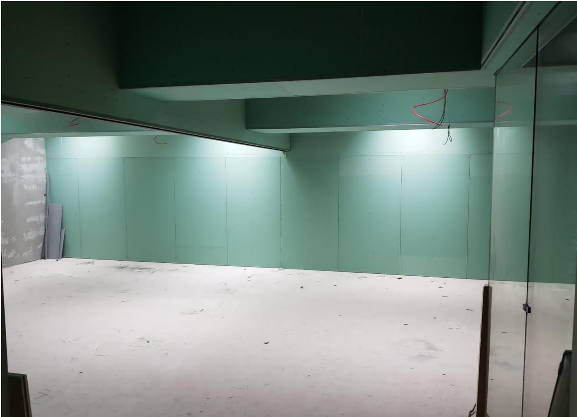
FIG.9 – Vista sull'attuale locale deposito oggetto dell'intervento.
