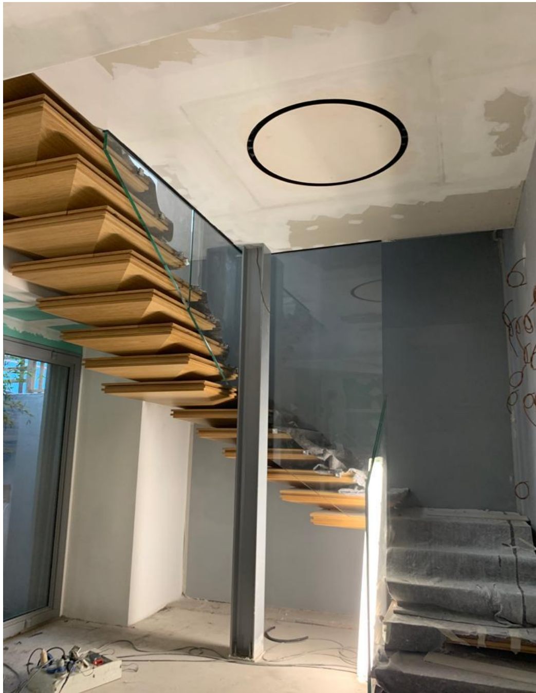
FIG.8– Vista della scala interna che collega il piano terreno con l'interrato.
