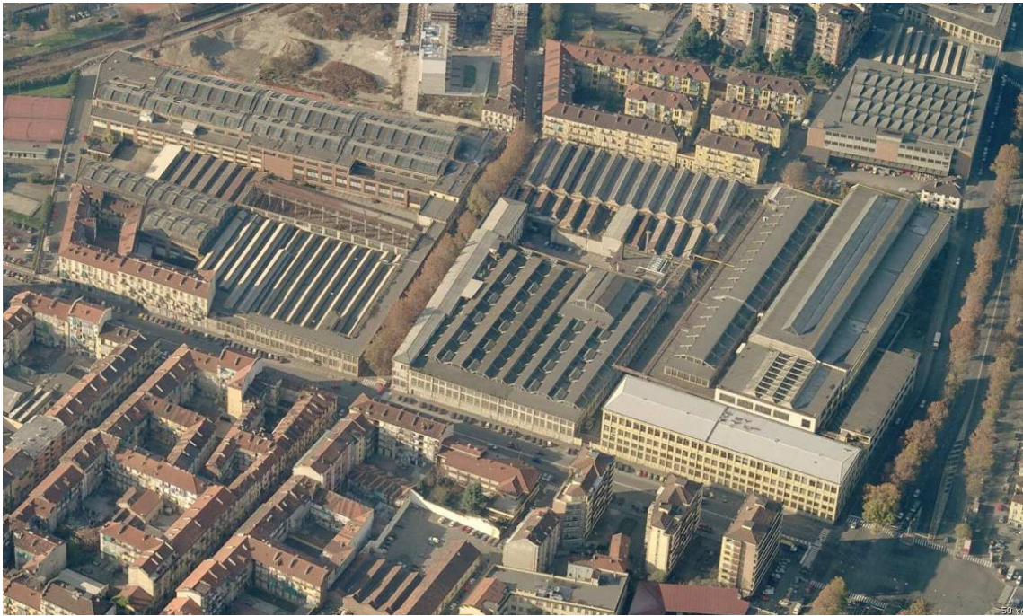
FIGURA 3 - VISTA PRIMA DELLE DEMOLIZIONI
