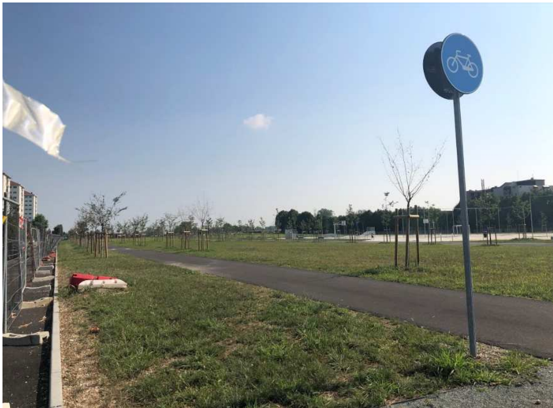
Vista del Parco P25- Laghetti Falchera in fase di completamento
