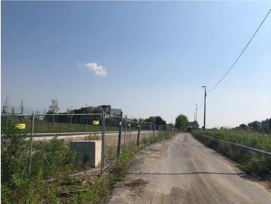
Tracciato viabile esistente e Parco P25- Laghetti Falchera in fase di completamento
