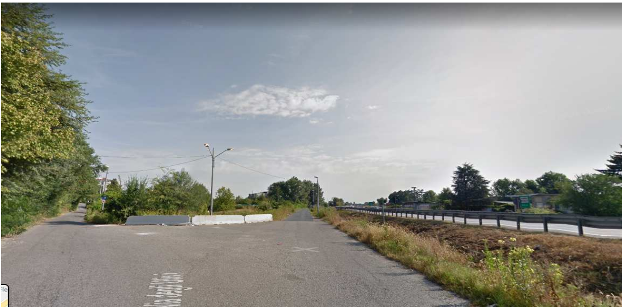
Tracciato viabile esistente ( collegamento con via delle Querce) nell'area attualmente destinata a Parco P25
