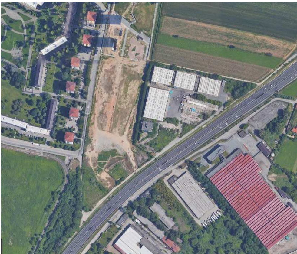
Vista aerea dell'area nel Comune di Settimo Torinese e del Parco P25 in corso di realizzazione
