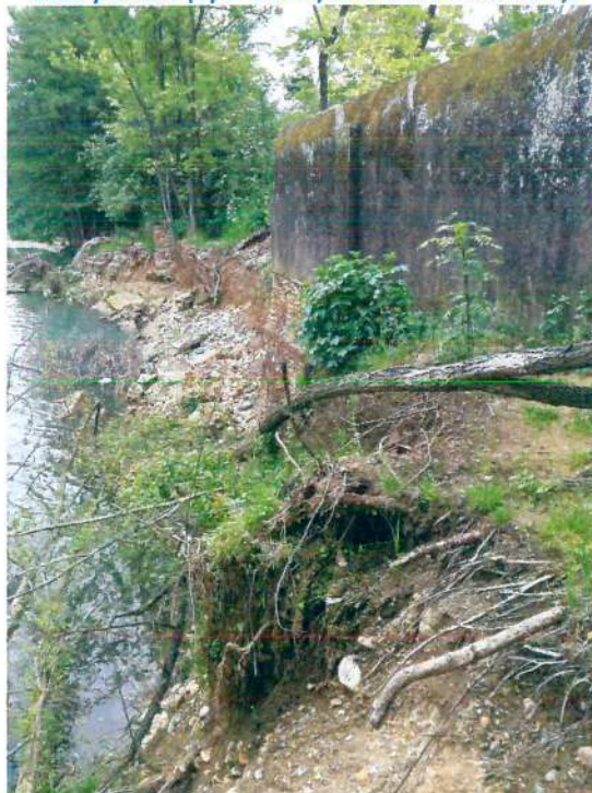
FOTO 6 – Sponda destra del Ceronda immediatamente a valle dello scarico della centrale per la quale si prevedono interventi di sistemazione mediante realizzazione di una scogliera e il ripristino della pista ciclabile.
