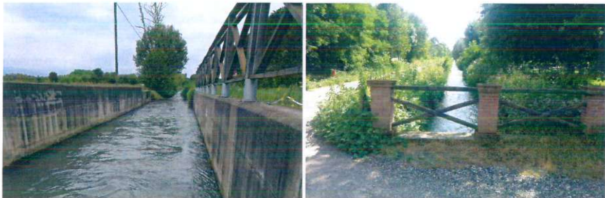
Figura 4 – Naviglio di Druento nel tratto terminale poco a valle di cave Druento, laddove si ha il passaggio della sezione rettangolare in c.a. a sezione prismatica in terreno naturale e vista a ridosso dei campi da golf.
