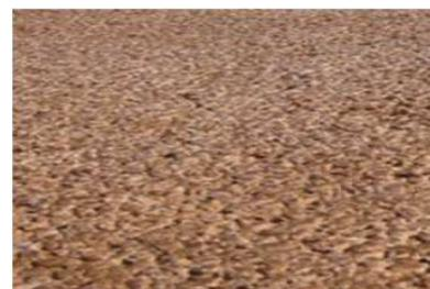
Figura 10: Esempio di pavimentazione in cls drenante
