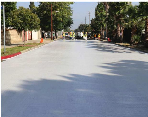
Figura 12: Esempio di pavimentazione in asfalto con rivestimento ad elevato albedo - Los Angeles, California
