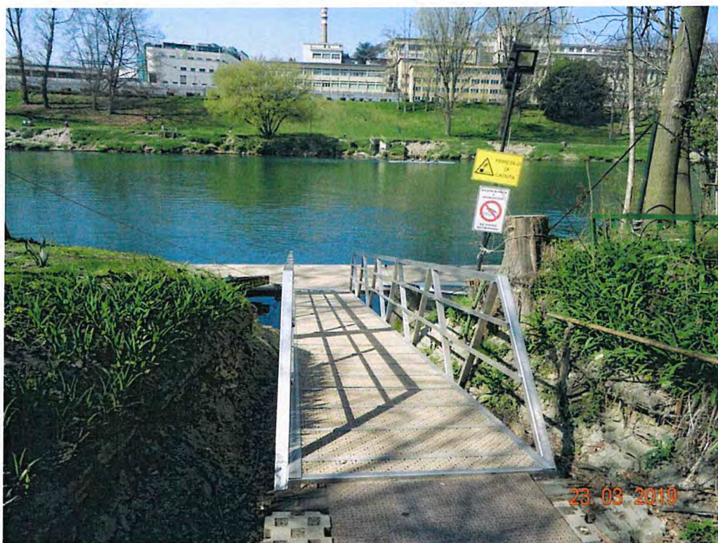
Figura 2-13 – CUS Torino - Passerella di accesso all'imbarco correttamente rimovibile. Anche la rimozione delle barche è attuabile mediante apposito argano (foto 2595- DSC04290)
