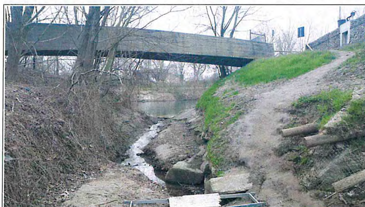
Foto 3 – Tratto terminale del Rio Sappone all'estremità sud dell'area Fioccardo con vista della passerella ciclopedonale di attraversamento
