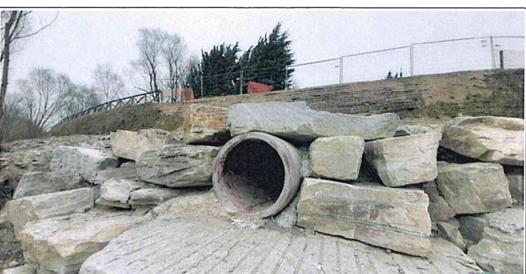
Foto21 – Tubo di scarico della nuova rete fognaria realizzata tra l'area dei Ronchi Verdi e l'A.S.D. Master Club Fioccardo
