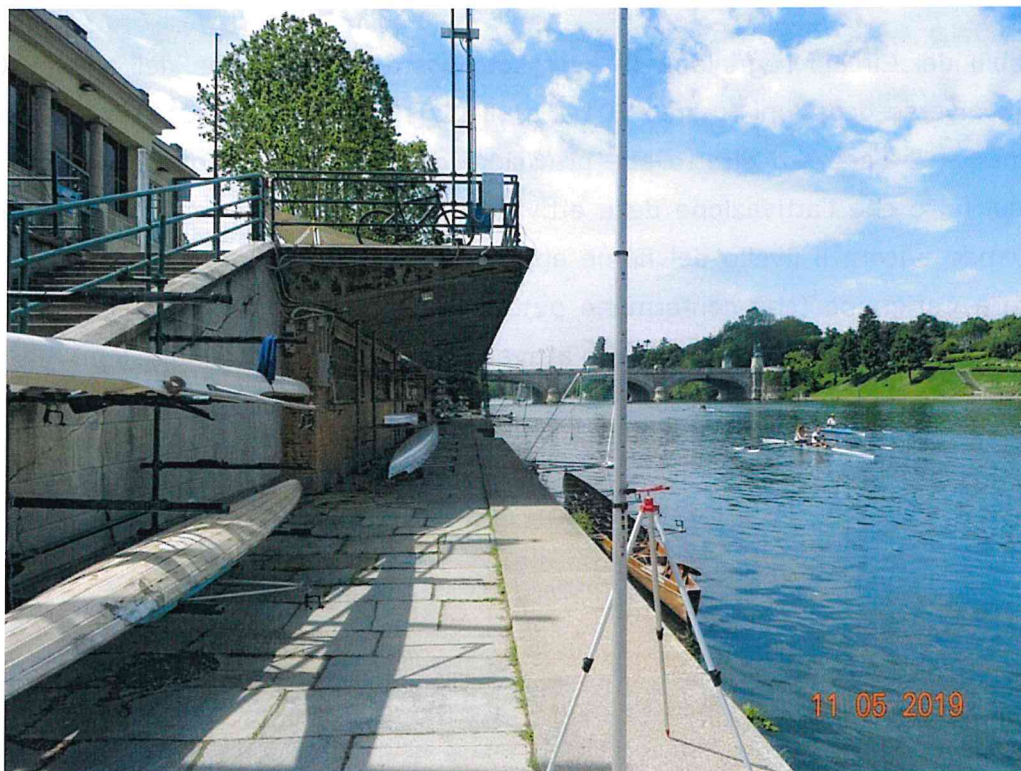
Figura 2-20 – Circolo Amici del Fiume – Banchina di attracco (foto 2619- DSC04424)
