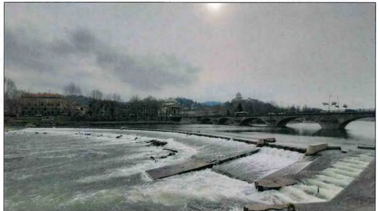
Foto 20 – Vista della Diga Michelotti
