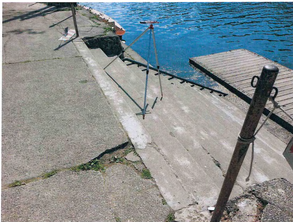
Figura 2-17 – Discesa verso fiume. Al secondo scalino dall'alto corrisponde il livello dell'allerta gialla (215.40 m s.l.m., valore di fatto confrontabile, alla sezione 480 nel modello numerico, con la quota 215.33 corrispondente alla portata di 680 m 3 /s che figura come 2° valore di portata di riferimento nel bollettino di Previsione delle piene).
