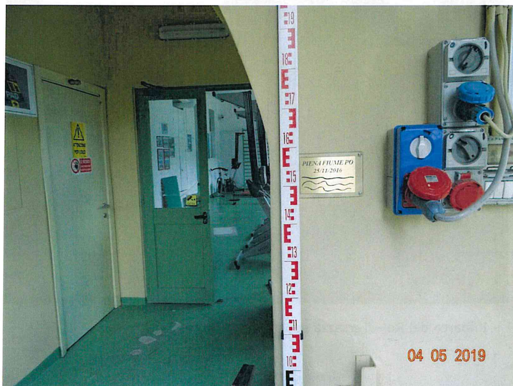
Figura 2-6 – La targa con il segno della piena del 2016 alla Canottieri Armida (la quota del pavimento è 217.03 m s.l.m.)
