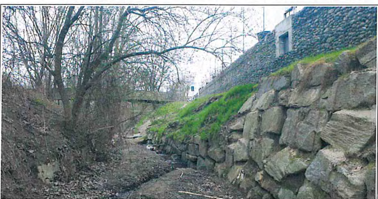
Foto 4 – Fasce spondali ed elementi di difesa lato A.S.D. Master Club Fioccardo nel tratto finale del Rio Sappone
