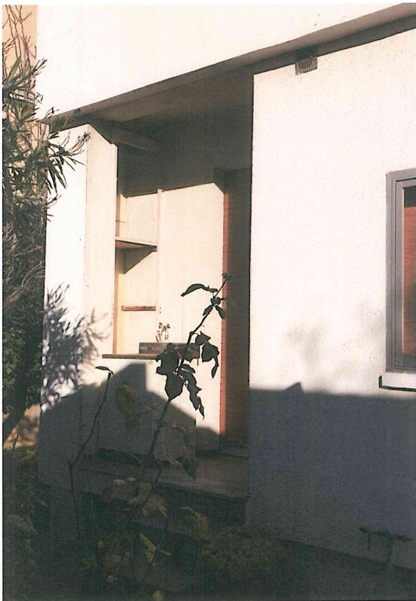
Lato sud - dettaglio facciata edificio principale - affaccio attuale bagno
