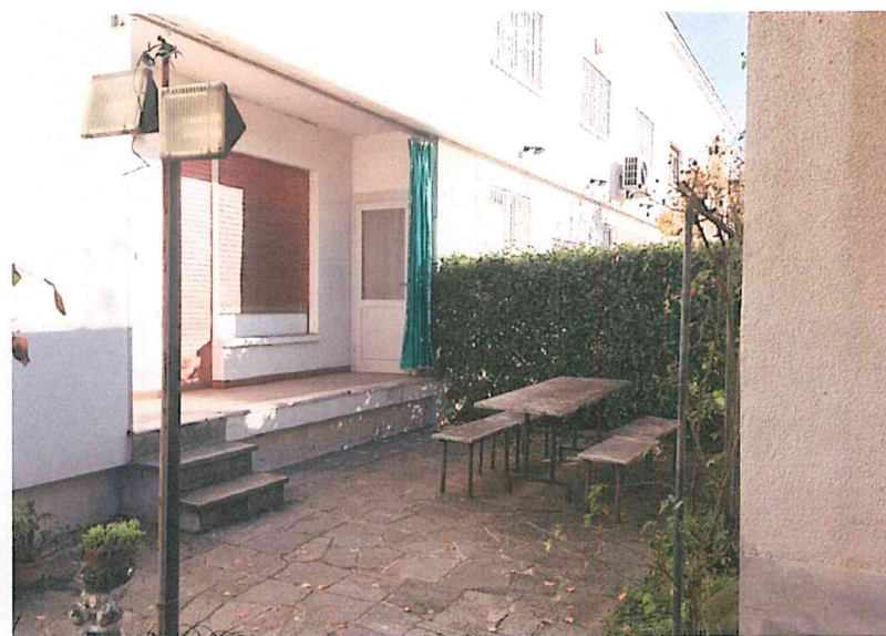
Lato sud - dettaglio facciata edificio principale verso il basso fabbricato
