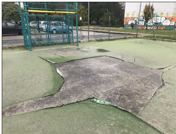
rifacimento della pavimentazione del campetto polivalente
