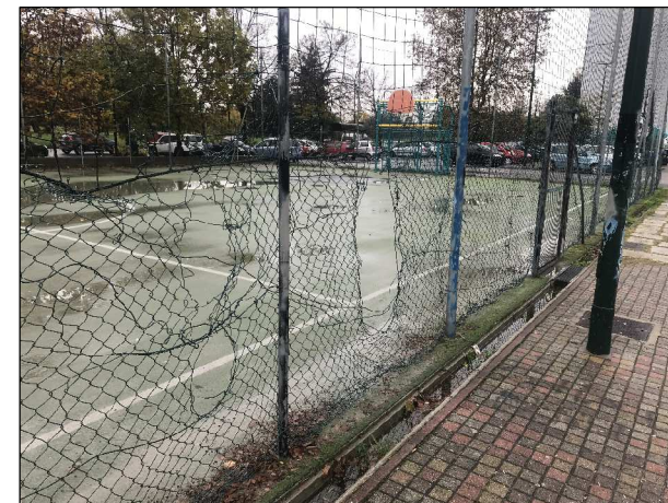
ripristino della recinzione del campetto polivalente
