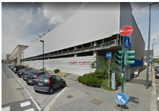
Porzione di facciata della porzione di vendita della Ex Succursale di Vendita Fiat da sostituire con nuova facciata in pannelli di colore chiaro.
