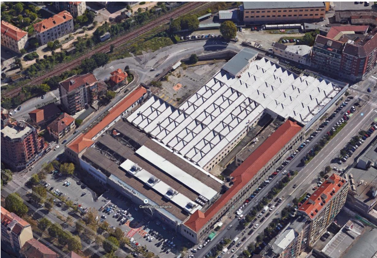
Fig.4 - Vista a volo d'uccello da sud-ovest.
