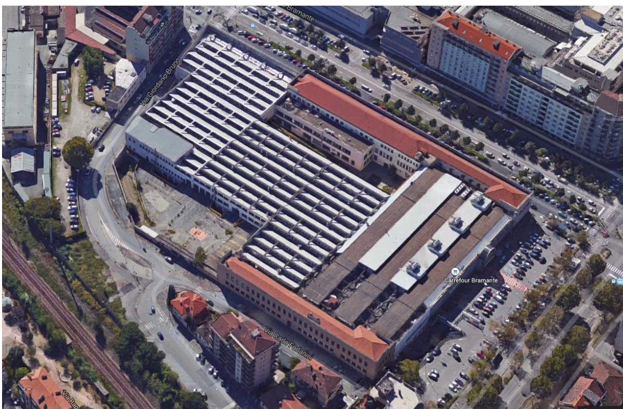
Fig.5 - Vista a volo d'uccello da nord-ovest.
