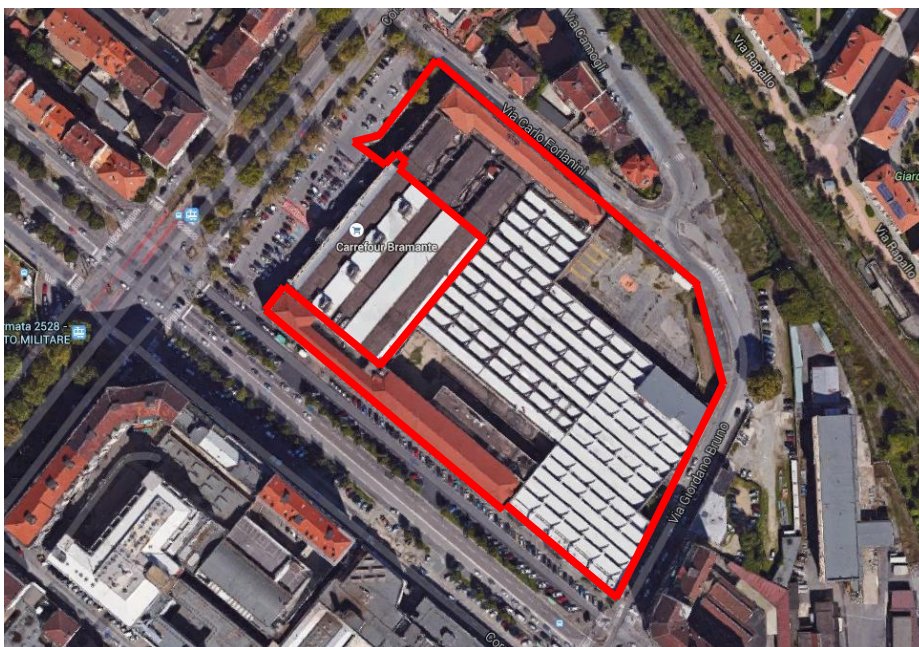
Fig.2 - Vista zenitale dell'area di intervento (evidenziata in colore rosso) - dettaglio.
