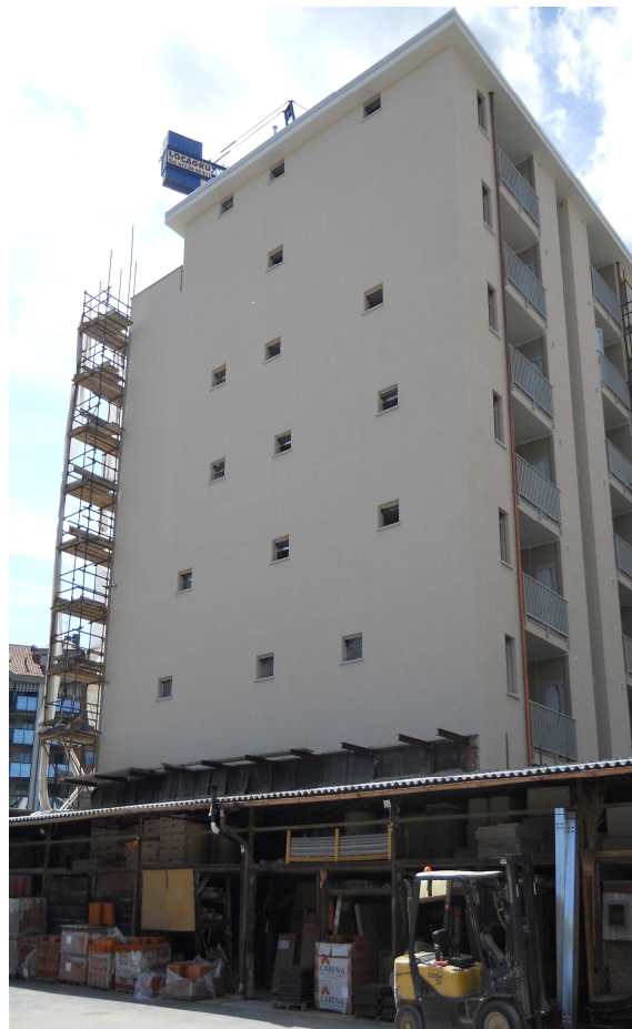
Vista interno cortile dell'immobile in via Barletta 127
