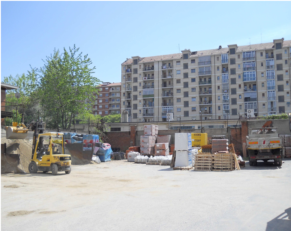
Vista interno cortile dell'immobile in via Barletta 127
