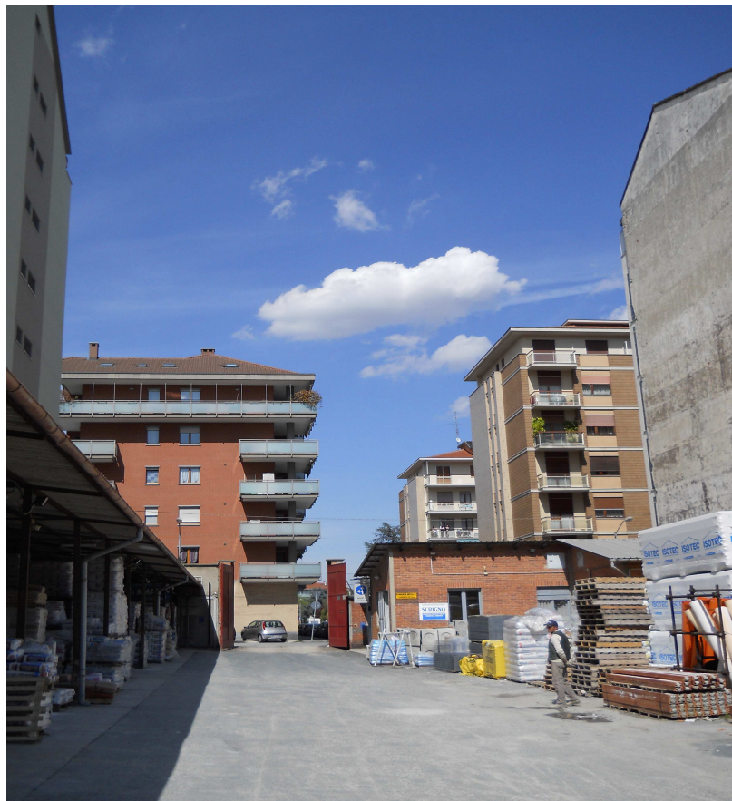
Vista interno cortile dell'immobile in via Barletta 127
