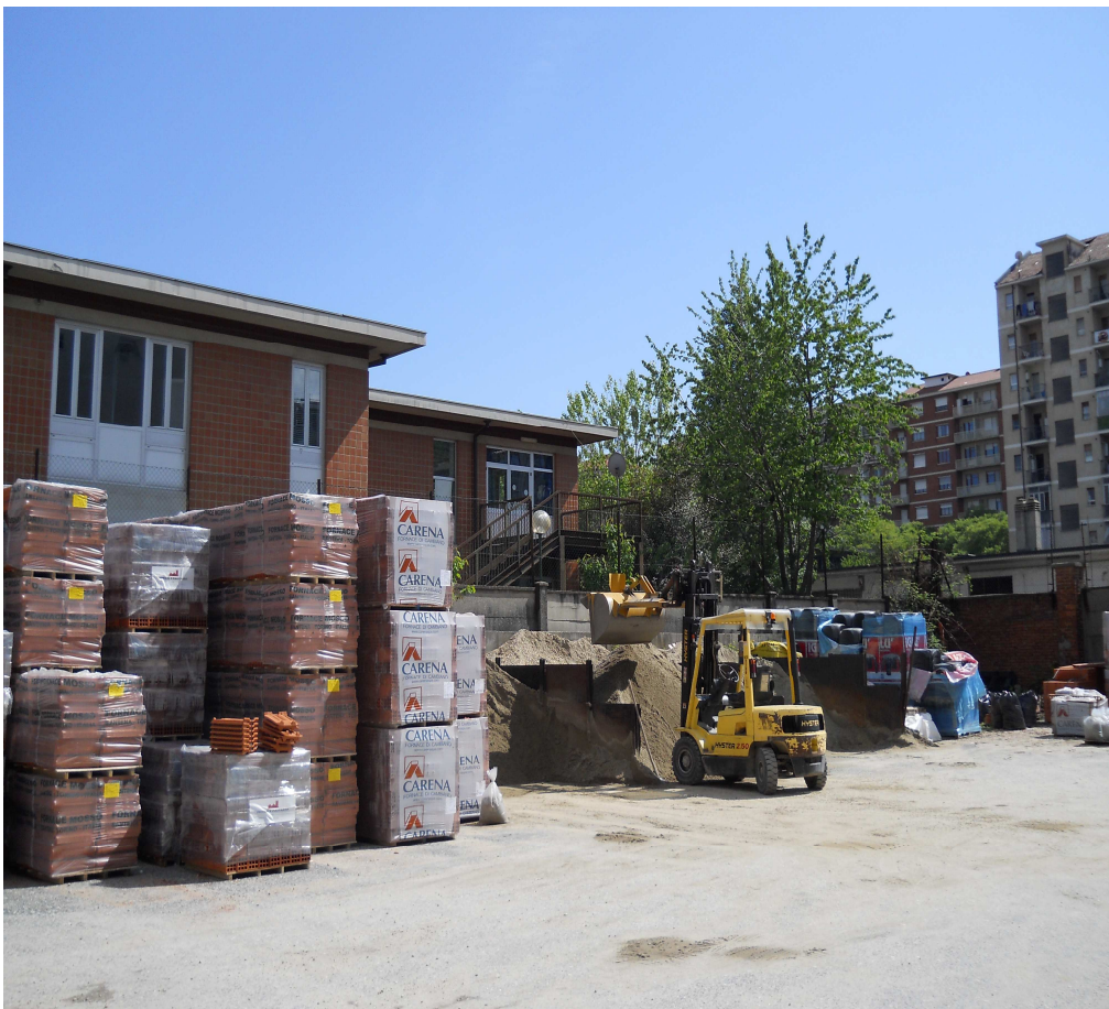
Vista interno cortile dell'immobile in via Barletta 127
