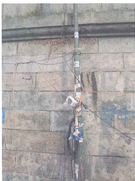
Allacciamento volante e probabilmente abusivo all'energia elettrica da parte di un furgone per la somministrazione di alimenti
