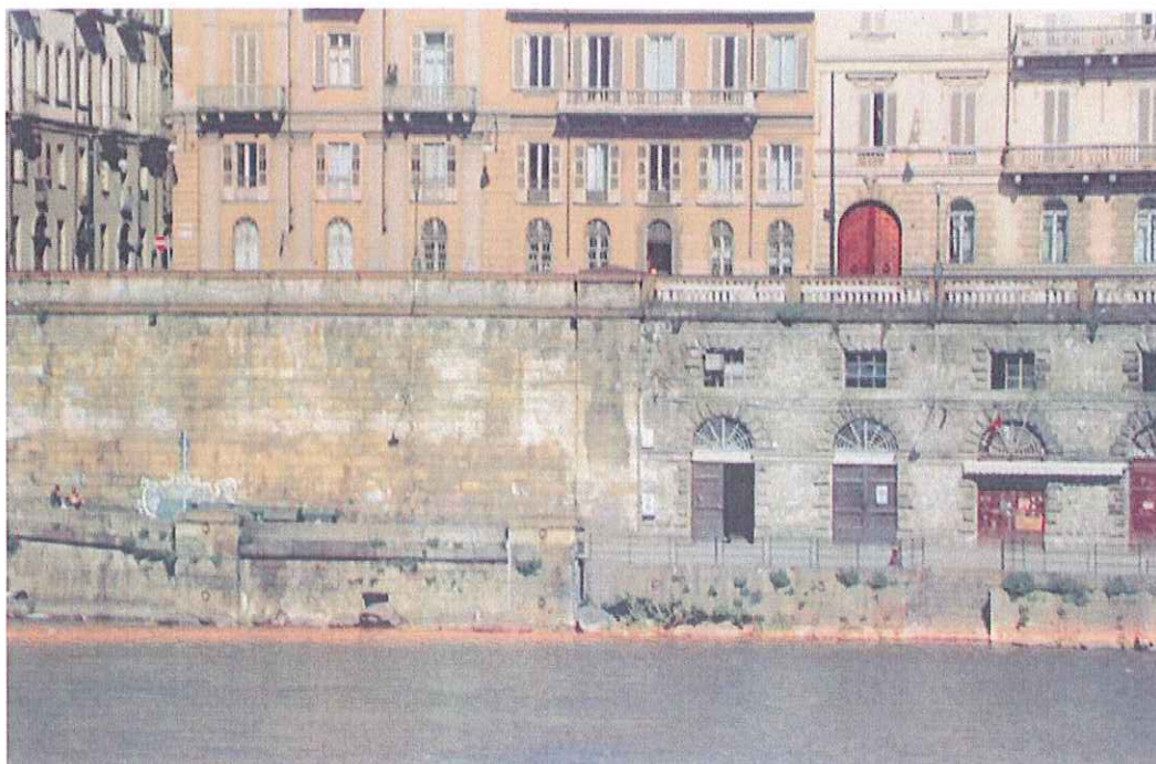
Fig. – L'immagine Evidenzia (oltre al profondo stato di degrado) il netto distacco fra i quais di Mosca e i murazzi
