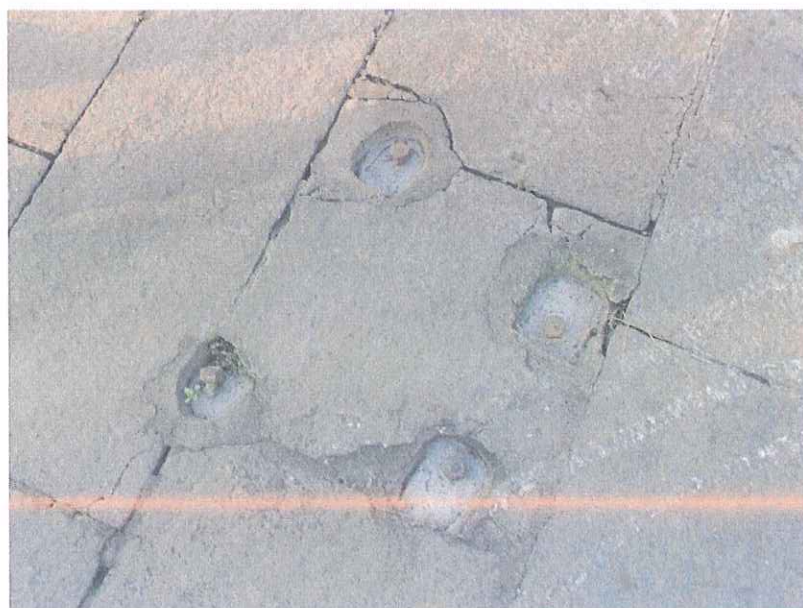
Pietre forate da tasselle dove sono stati rimossi i dehors lungo l'argine
