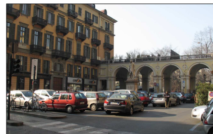
piazza Lagrange da via Lagrange
