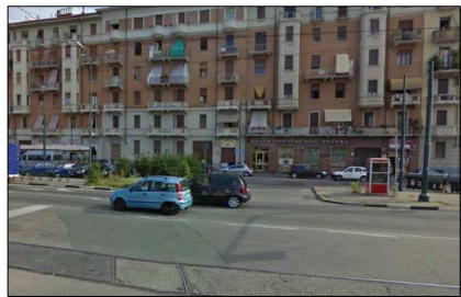
l'area vista da via Stradella
