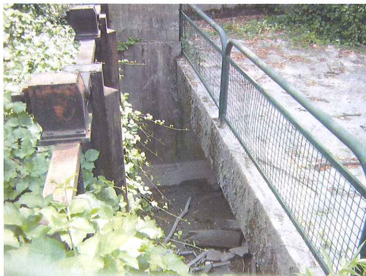
Foto 2 – Particolare dell'opera di presa del canale Pellerina sulla traversa sulla Dora.
