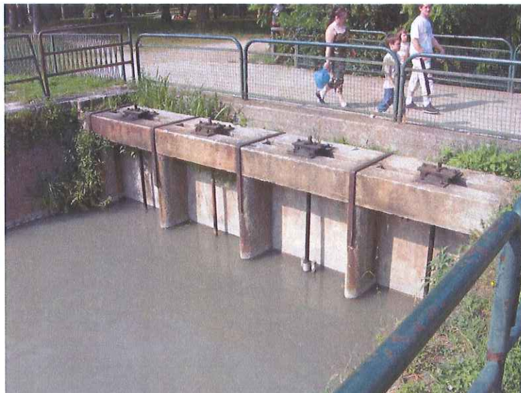
Foto 5 – Paratoie di regolazione del canale dissabbiatore – sghiaiatore.
