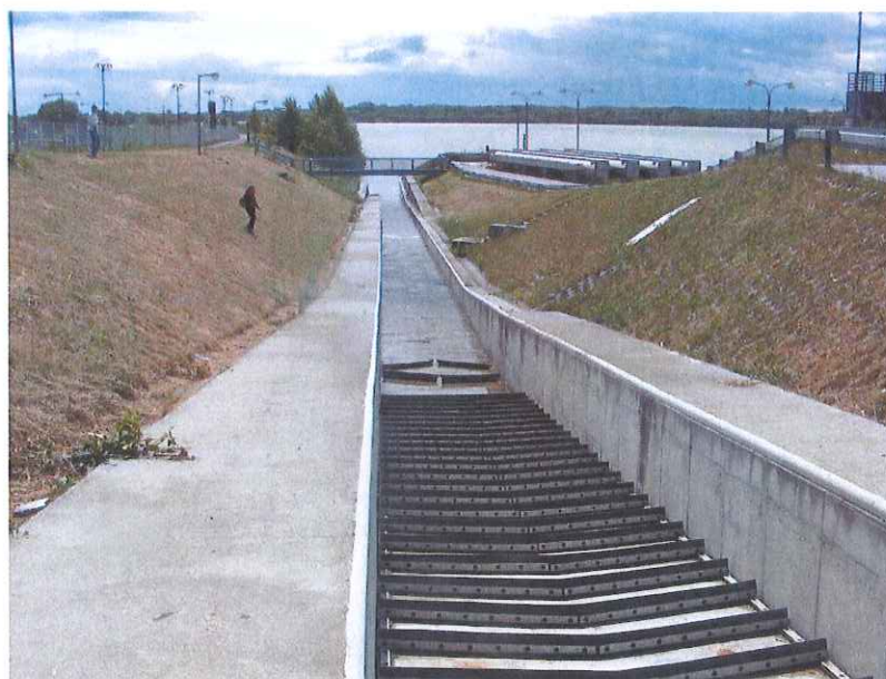
Figura 9 – Tipologia di passaggio per canoe
