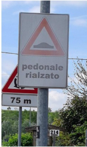
Str. Villaretto Cartello di pericolo per pedonale rialzato molto scolorito
