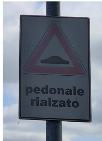
Str. Villaretto Cartello di pericolo per pedonale rialzato molto scolorito
