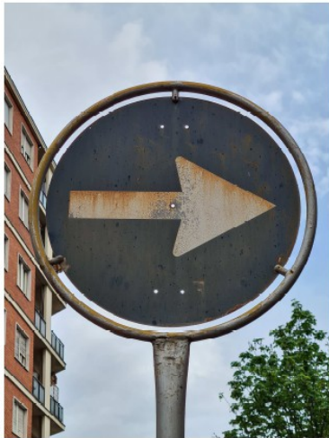
Via Valdengo 4 Cartello di direzione molto scolorito
