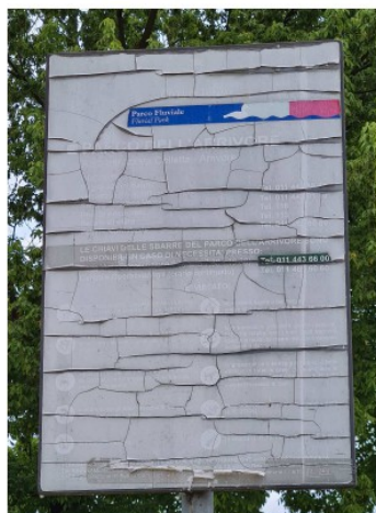
Parco dell' Arrivore su via Botticelli Cartello di informazioni con n. di emergenza illeggibile e da aggiornare
