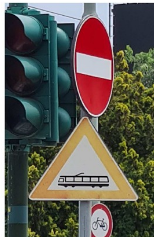
Piazza Derna Cartello di pericolo passaggio tram molto scolorito
