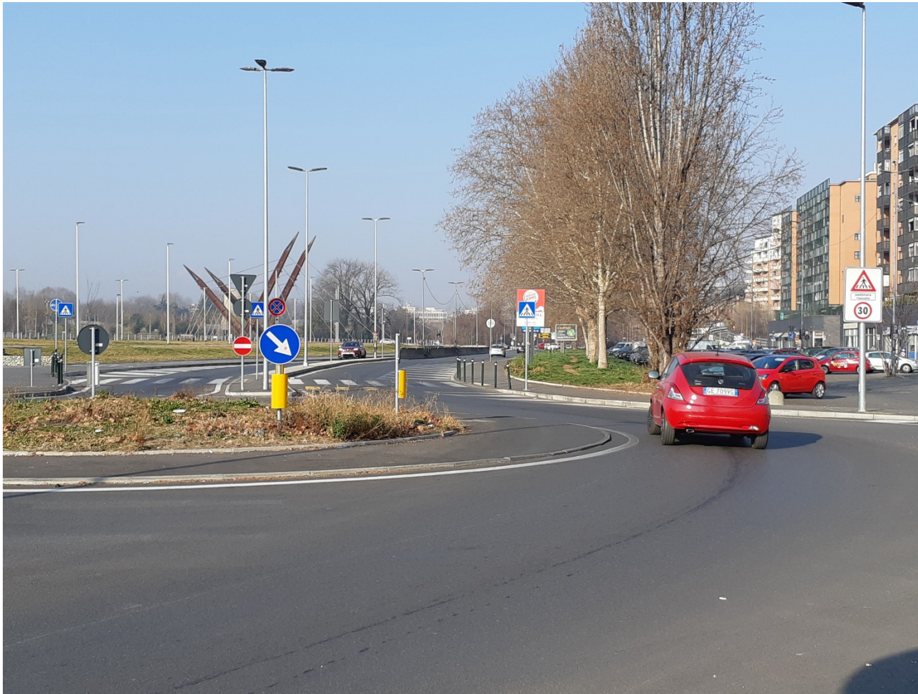
Corso Mortara nuova rotatoria con attraversamenti pedonali rialzati per collegamento col Parco
