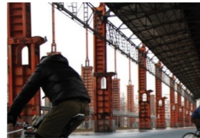
Figura 11: Pavimentazione in cls presso il Parco Dora - Torino
