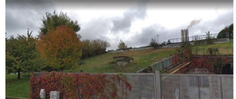
Figura 13: Facciate e coperture verdi presso l'area dell'Environment Park - Torino
