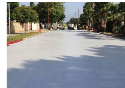
Figura 12: Esempio di pavimentazione in asfalto con rivestimento ad elevato albedo - Los Angeles, California
