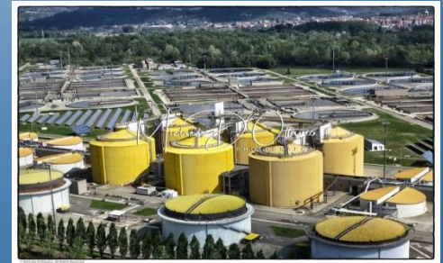
Ossidazione termica dei fanghi
