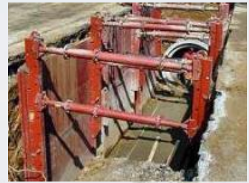
Scavo in trincea
