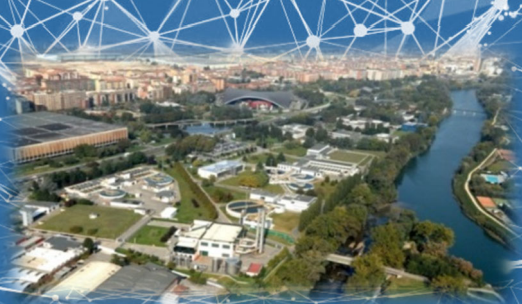
Impianto del Po
