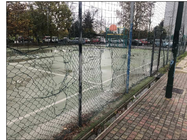
ripristino della recinzione del campetto polivalente
