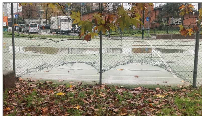
ripristino della recinzione del campetto polivalente
