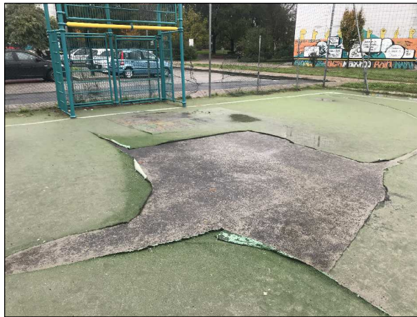
rifacimento della pavimentazione del campetto polivalente
