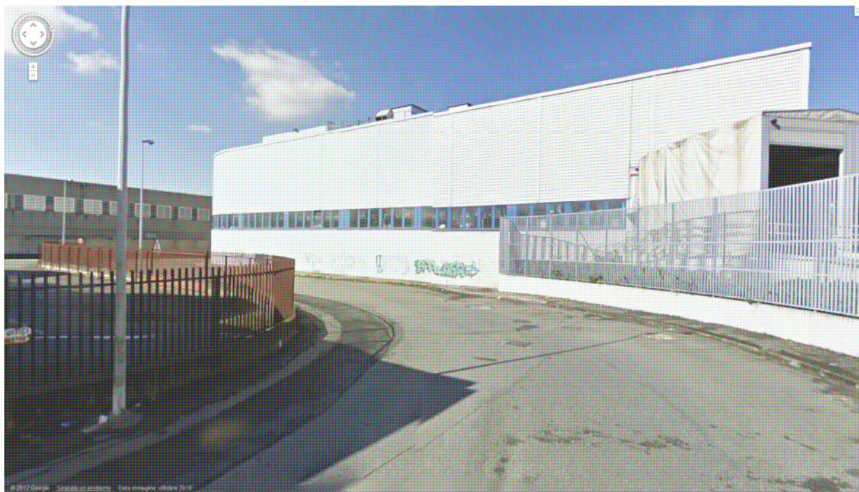
IL FRONTE SU CORSO PIEMONTE NEI COMUNI DI TORINO E SAN MAURO TORINESE FABBRICATO F
