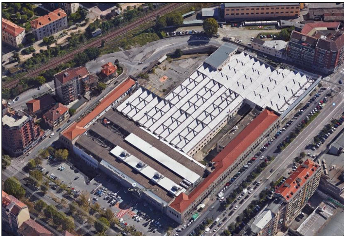
Figura 4 - Vista aerea prospetto sud-ovest (fonte Bing®)
