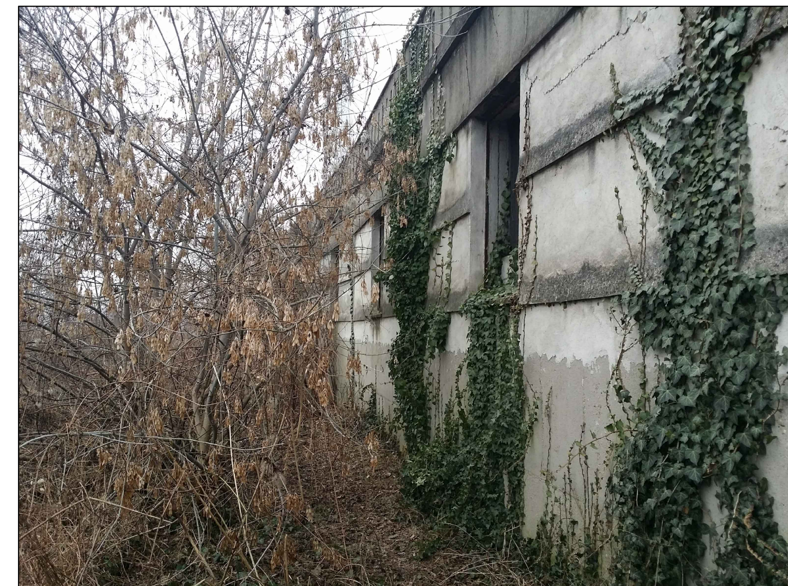
RIPRESA 6 - Parete prospiciente sulla linea ferroviaria
