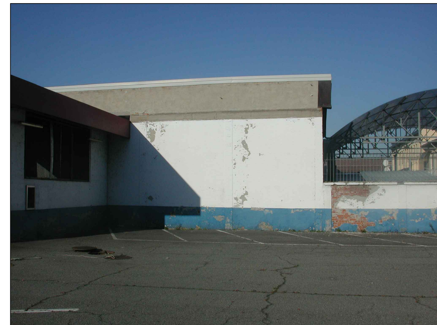
RIPRESA 4 - Fabbricato di altra proprietà a confine
