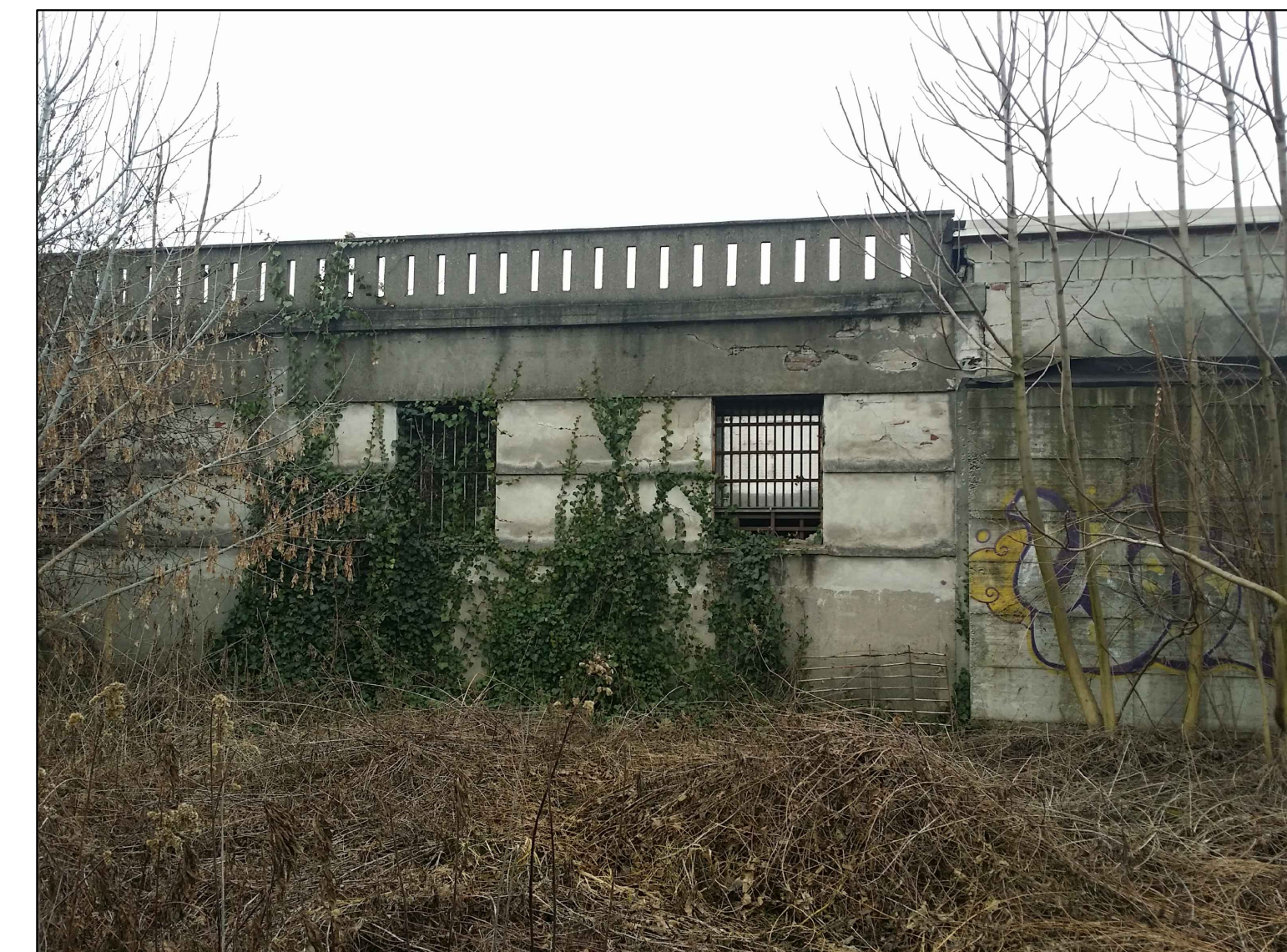
RIPRESA 8 - Parete prospiciente sulla linea ferroviaria
