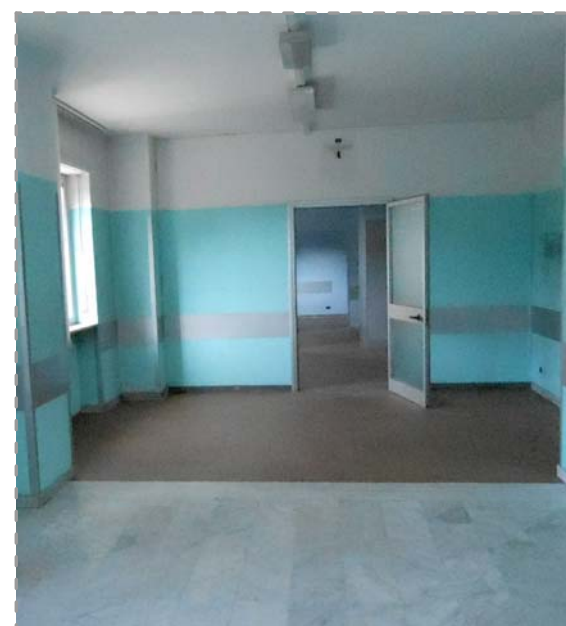
Vista interna 2 - stato di fatto piano primo
