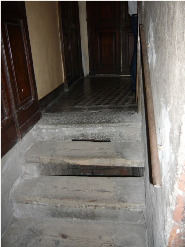
7: arrivo della scala dalla cantina
