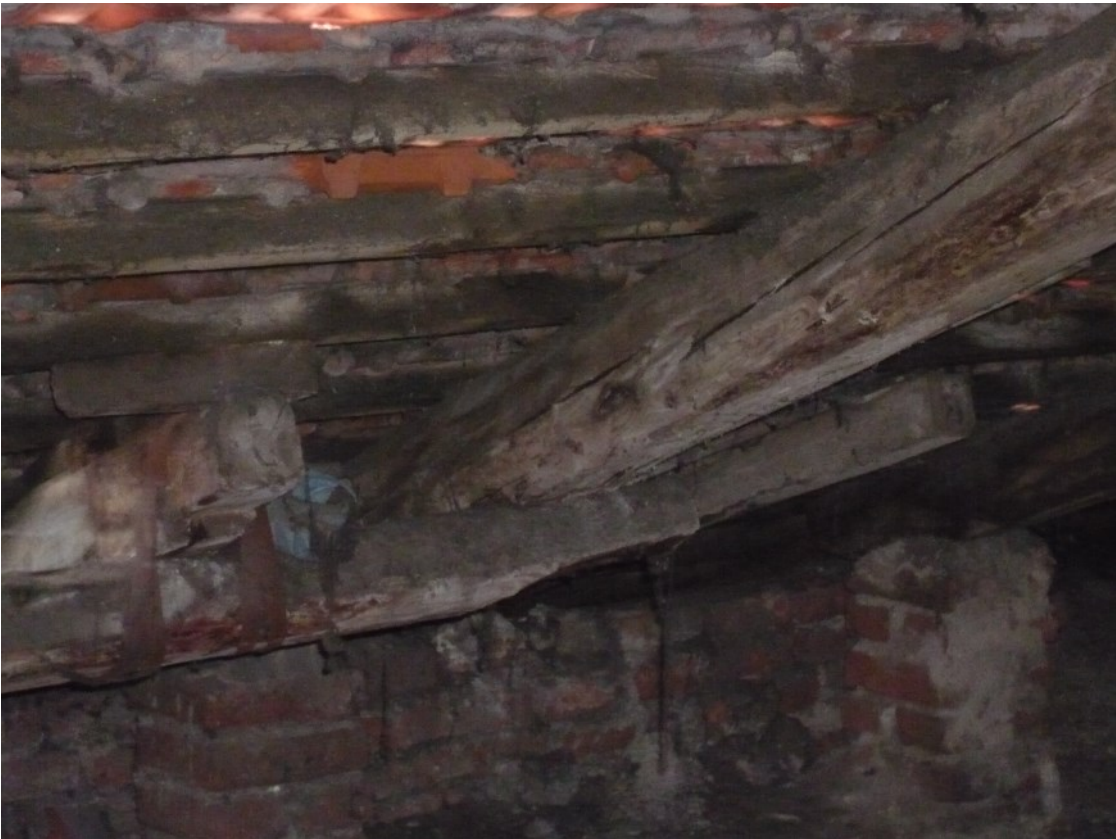
17: particolare delle travi del tetto
