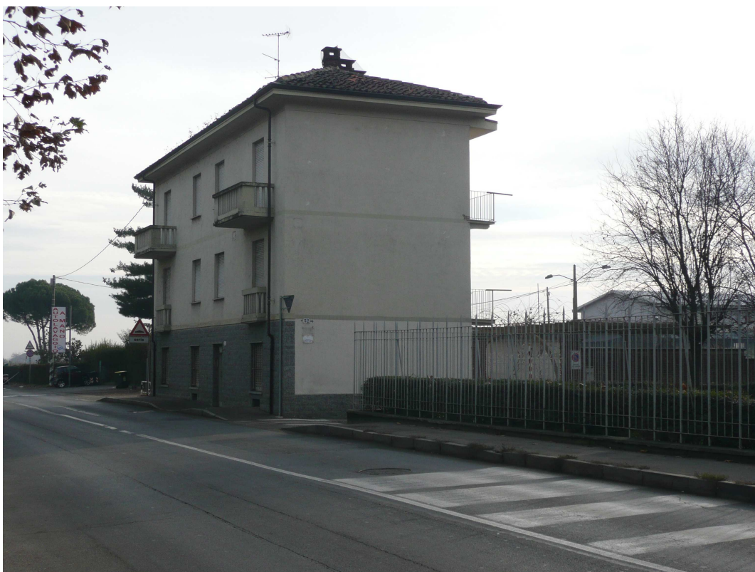
Foto 10 - Edificio in strada Castello di Mirafiori n. 54
