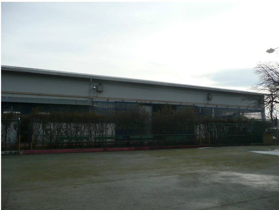
Foto 14 - Capannone industriale in strada Castello di Mirafiori n. 58
