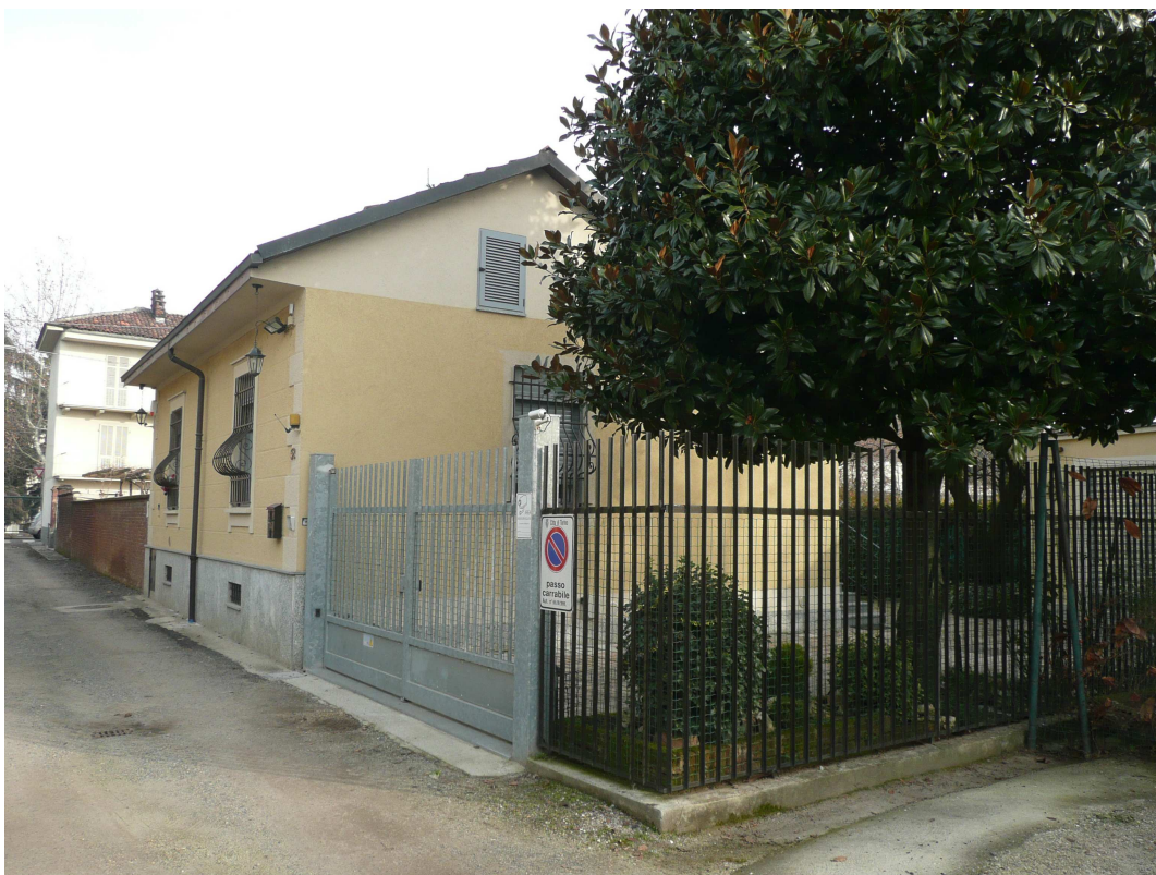
Foto 9 - Edificio in strada Castello di Mirafiori n. 52
