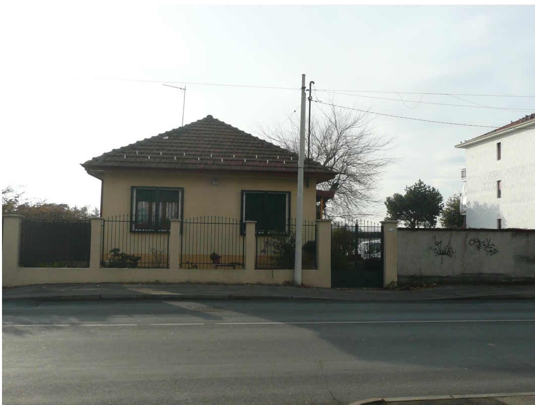
Foto 2 - Edificio in strada Castello di Mirafiori n. 14
