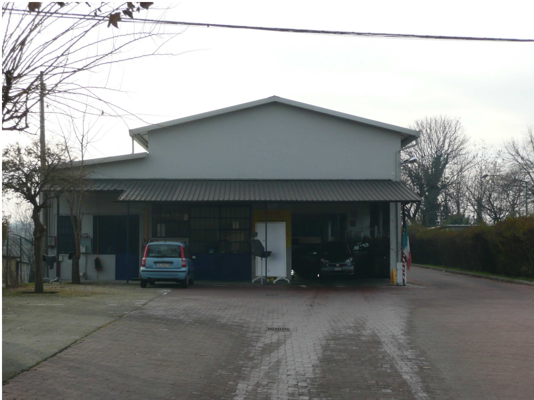
Foto 13 - Capannone industriale in strada Castello di Mirafiori n. 58
