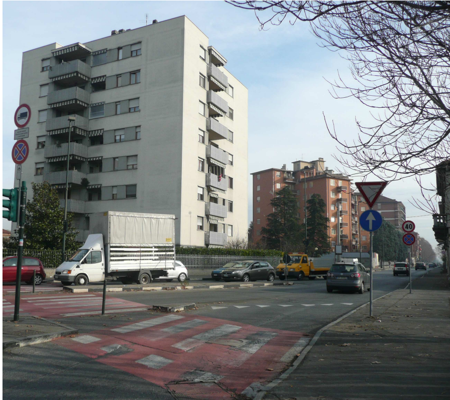
Foto 17 - Edificio in corso Unione Sovietica n. 611 angolo strada Castello di Mirafiori
