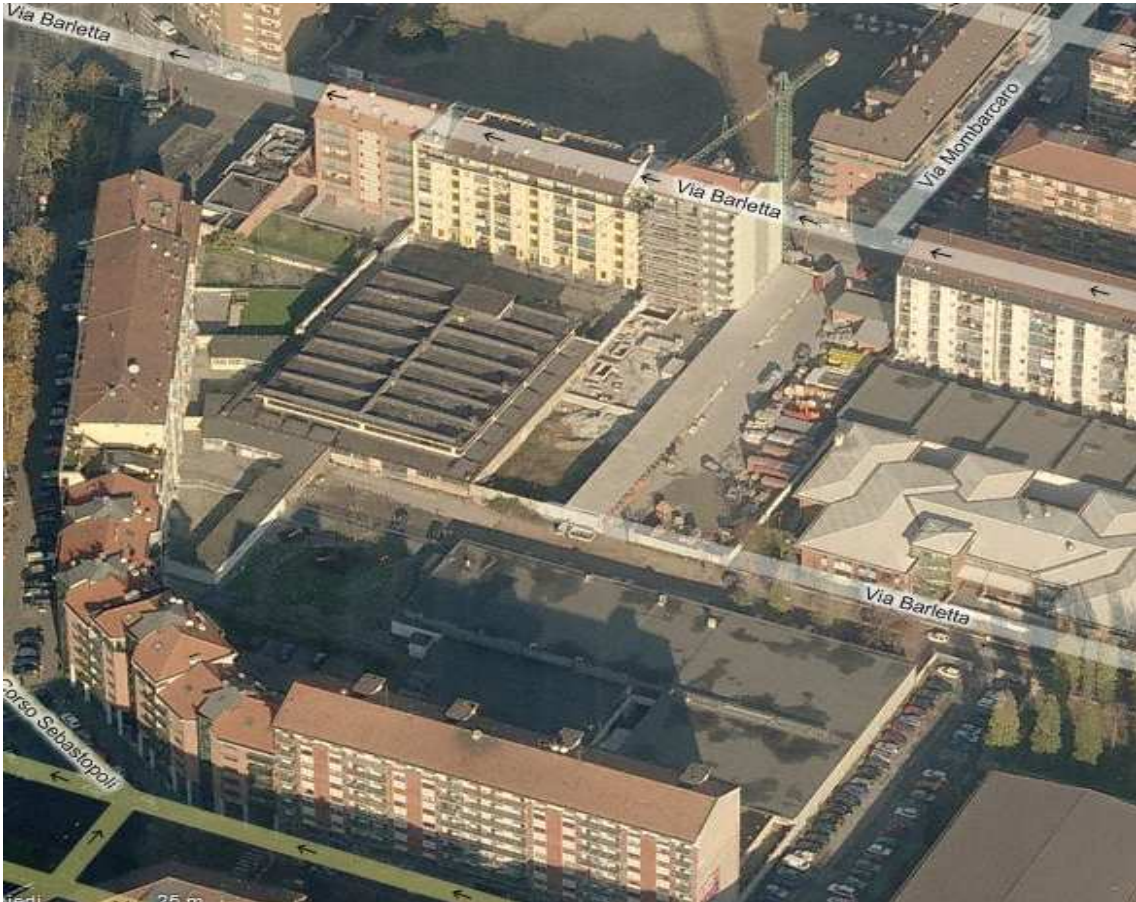
Vista aerea dell'immobile in via Barletta 127
