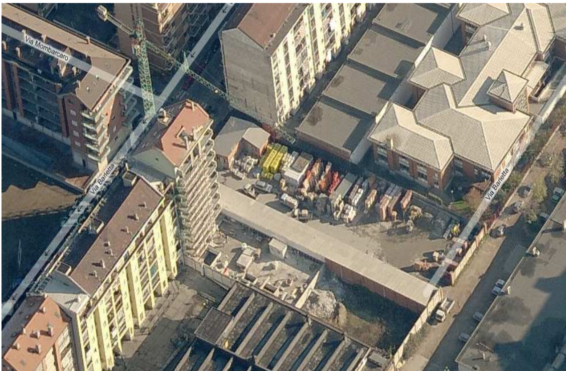
Vista aerea dell'immobile in via Barletta 127
