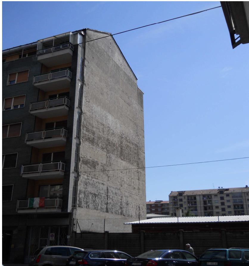
Vista laterale dell'immobile in via Barletta 127 angolo via Rovereto
