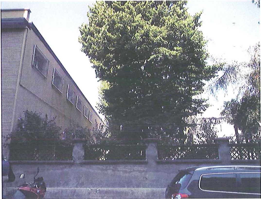
VEDUTA DEL PALAZZO LIMITROFO ALL'INGRESSO DI VIA CAPELLI 93
