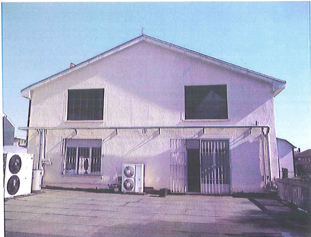
VEDUTA DELLA COPERTURA DELL'EDIFICIO DI VIA CAPELLI 93
