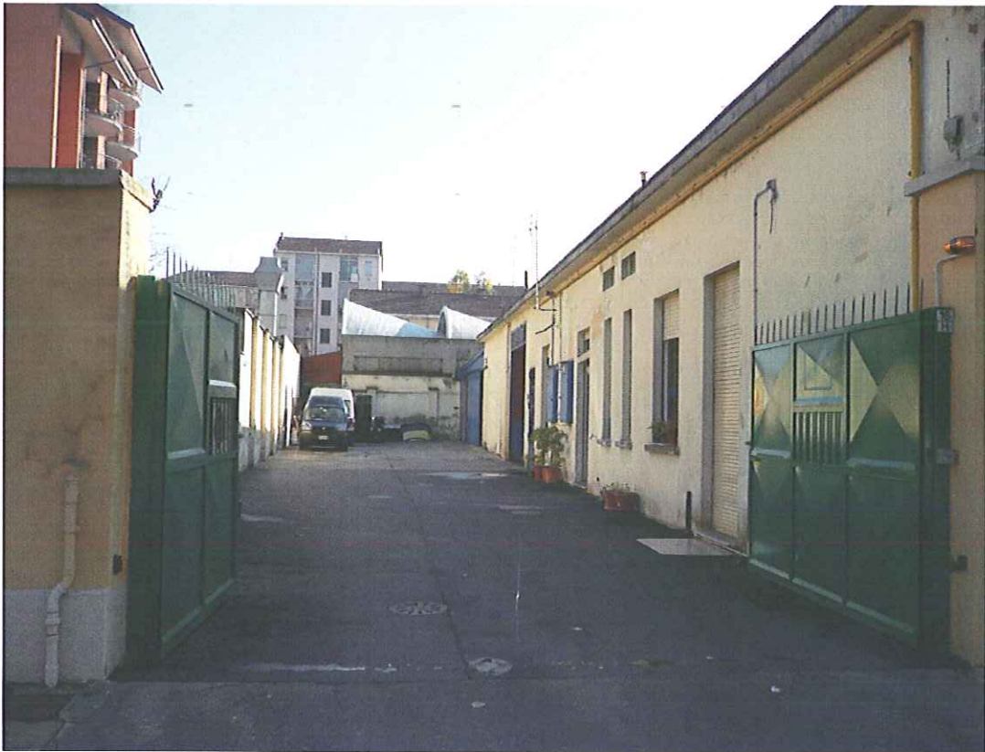
VEDUTA DEL CORTILE DELL'IMMOBILE DI PIAZZA CAMPANELLA 16
