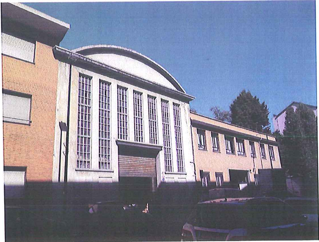
VEDUTA DELL'EDIFICIO DI VIA CAPELLI 87
