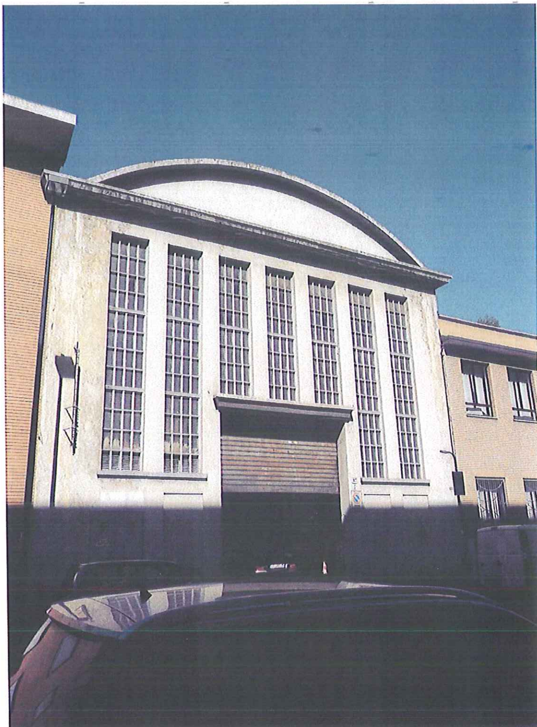
VEDUTA DELL'EDIFICIO DI VIA CAPELLI 87
