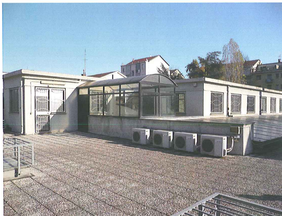
VEDUTA DELLA COPERTURA DELL'EDIFICIO DI VIA CAPELLI 89
