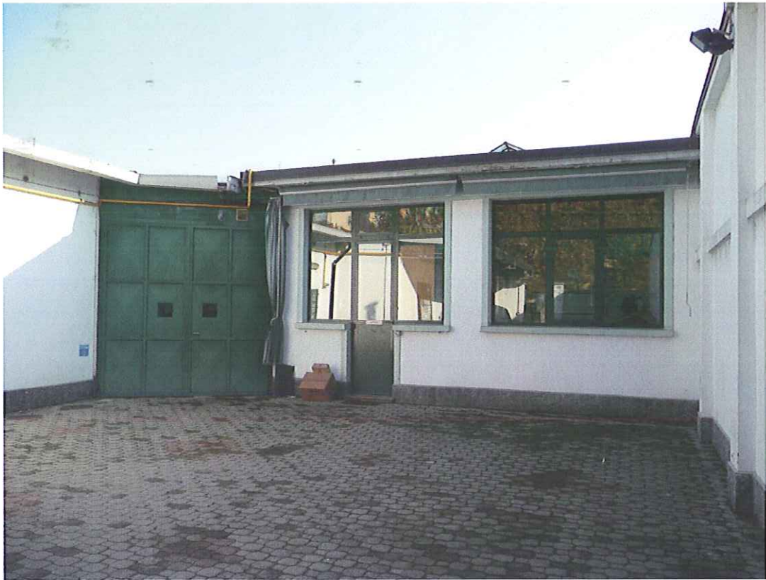
VEDUTA INTERNA DELL'IMMOBILE DI PIAZZA CAMPANELLA 14
