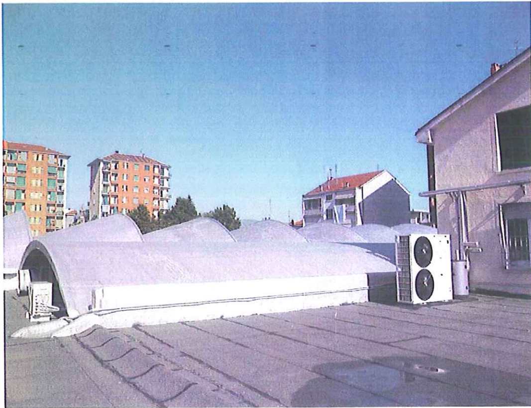
VEDUTA DELLA COPERTURA DELL'EDIFICIO DI VIA CAPELLI 93
