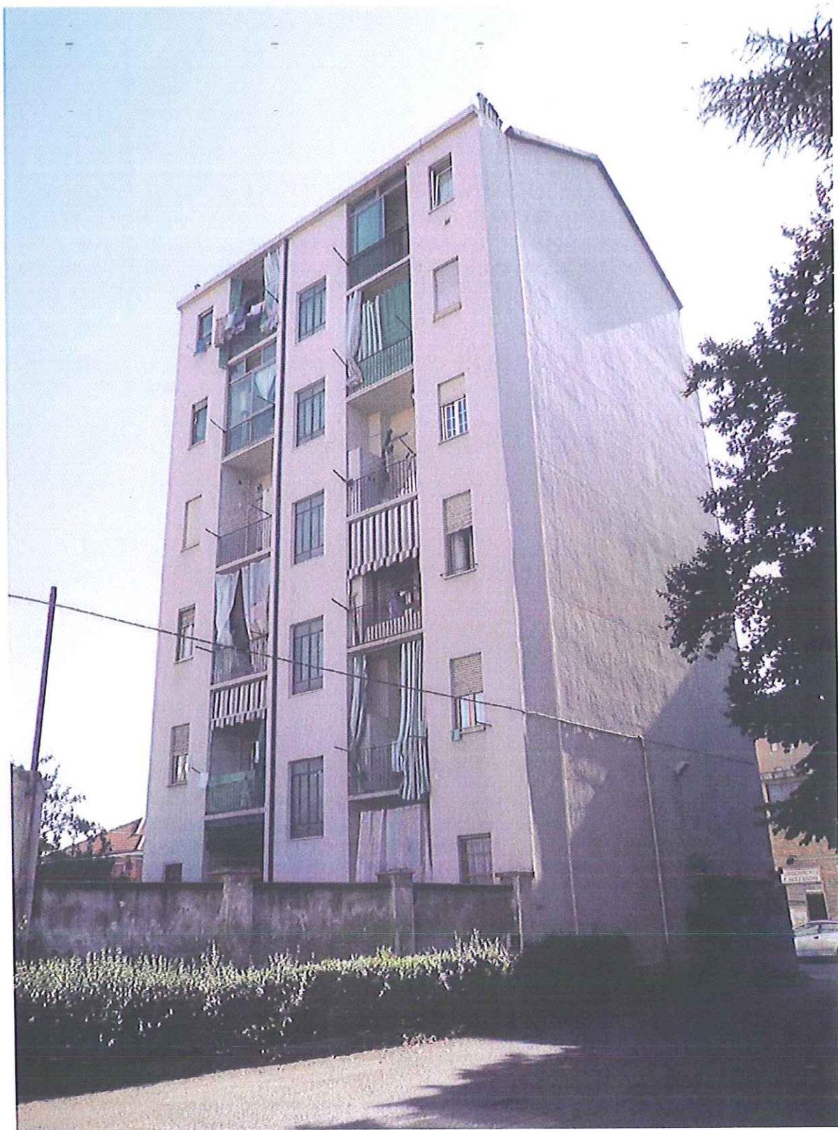
VEDUTA DEL PALAZZO LIMITROFO ALL'INGRESSO DI VIA CAPELLI 93
