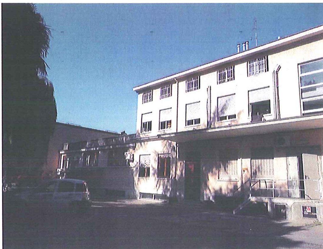
VEDUTA DELL'EDIFICIO DI VIA CAPELLI 93
