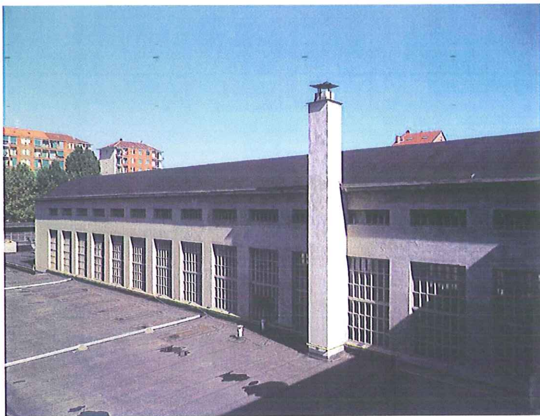
VEDUTA ESTERNA DELL'EDIFICIO DI VIA CAPELLI 87
