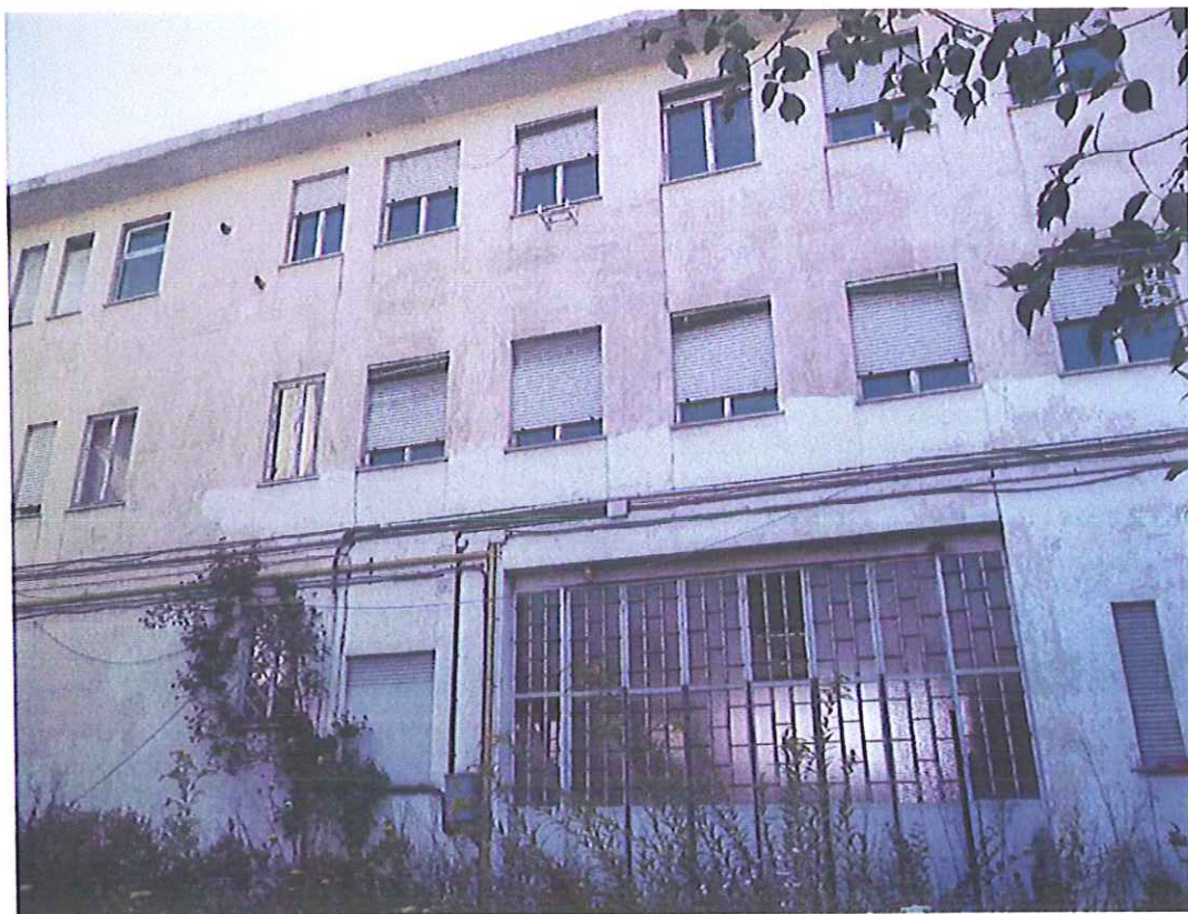
VEDUTA DAL CORTILE DELL'EDIFICIO DI VIA CAPELLI 85
