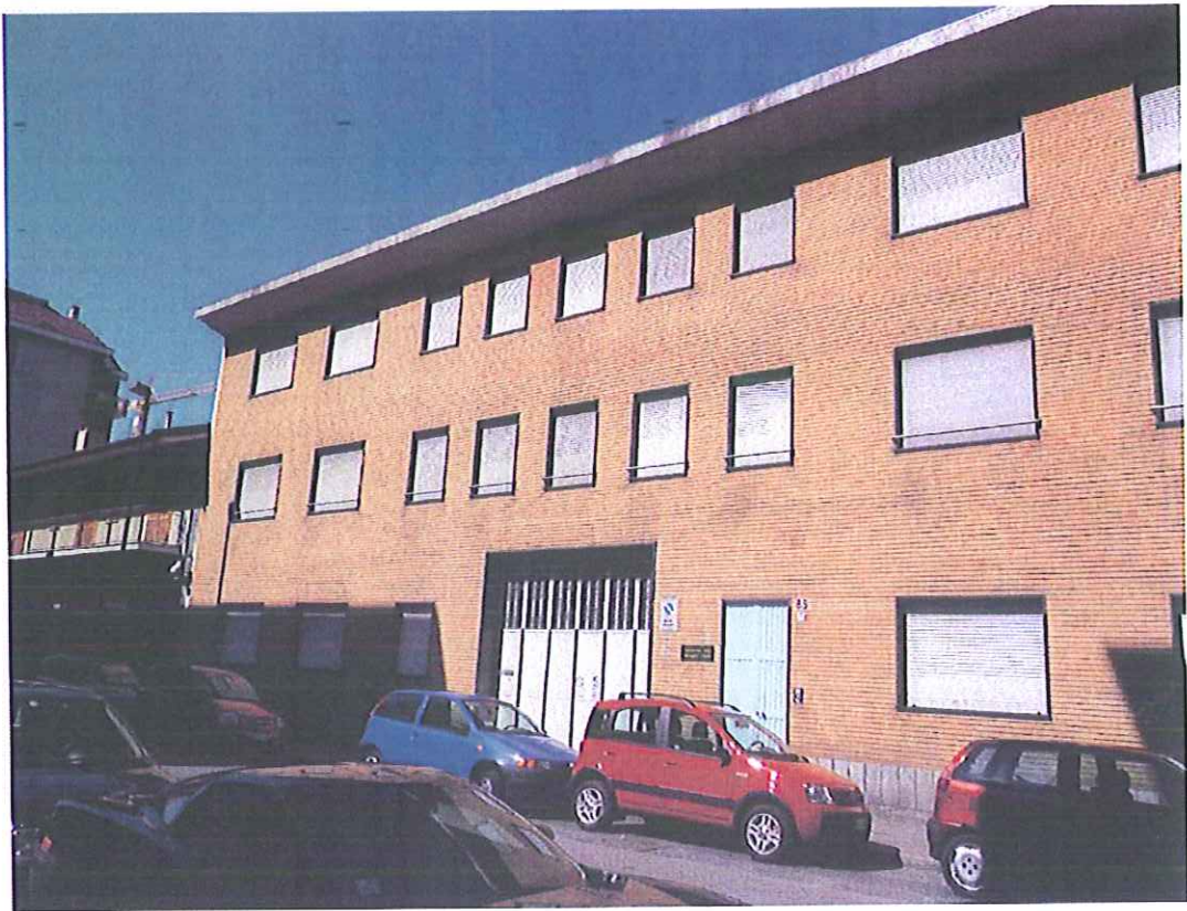
VEDUTA DELL'EDIFICIO DI VIA CAPELLI 85
