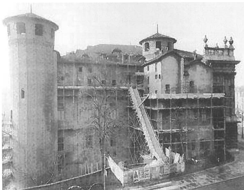
Fotografia del 1929 relativa ai restauri in corso
