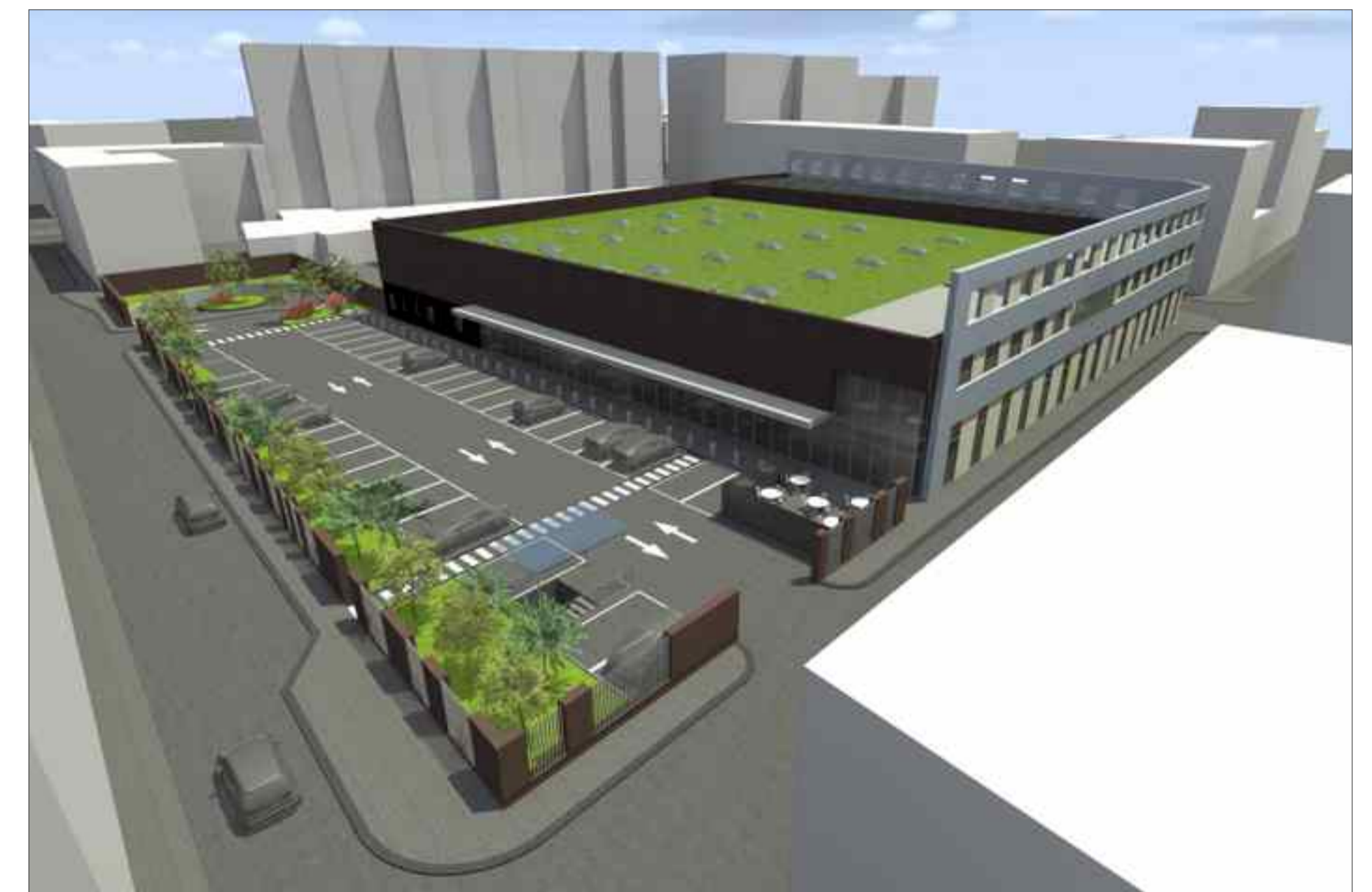
VISTA DAI FABBRICATI DI VIA LEINI' ANGOLO VIA FELETTTO
